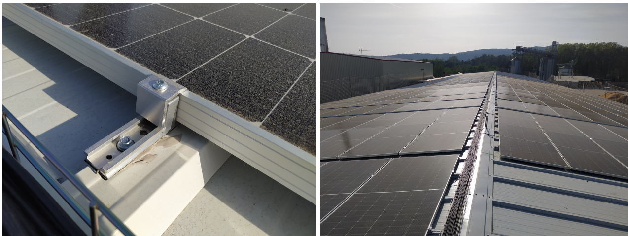
Imatges 2 i 3.- Instal·lació amb estructura de forma coplanar
