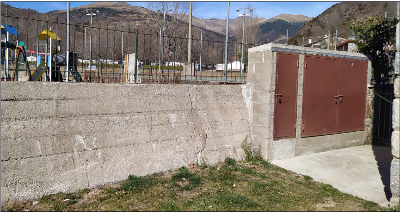
Imatge 1 - Armari de la centralització de comptadors existent
