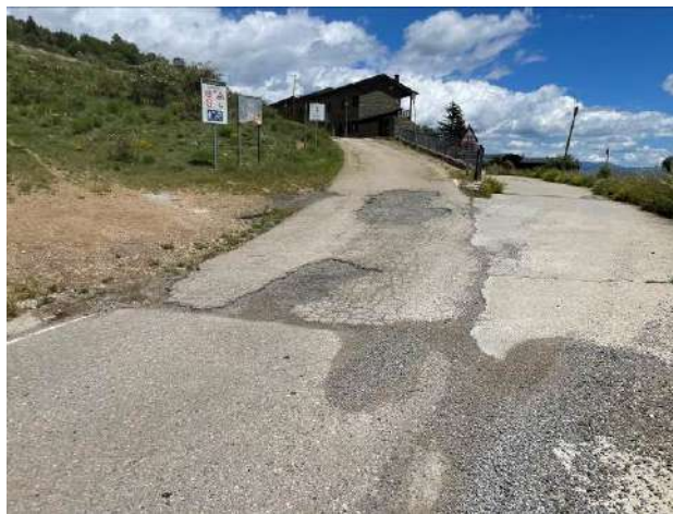
Imatge 01: Inici de l'actuació. Junta de paviment asfàltic al límit del nucli.
