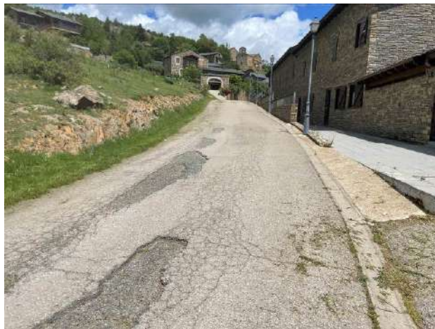
Imatge 02: Descrostonat de de paviment asfàltic i encintat lateral al núm. 17.
