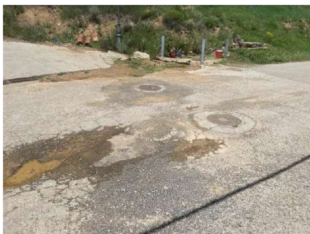
Imatge 13: Tram final de l'actuació al creuament amb el carrer de les Bassetes.
