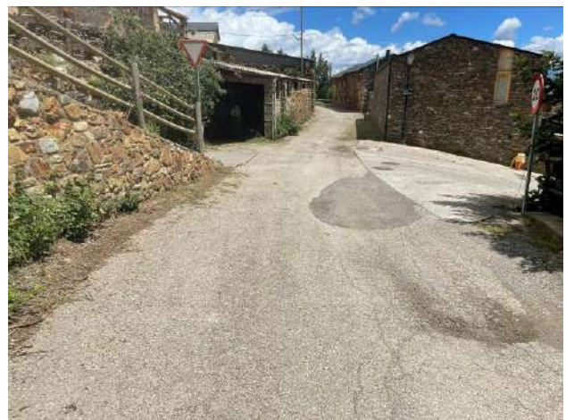
Imatge 06: Paviment asfàltic quarterat amb flonjall sobre el traçat del clavegueram.
