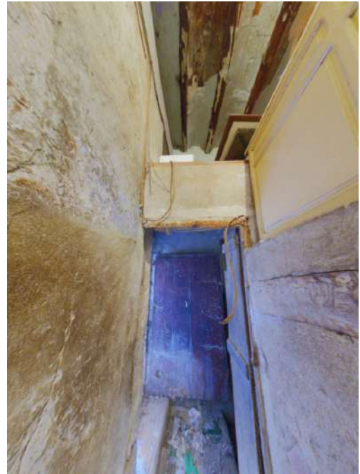
DF.18. Accés a l'antic forn de pa de la planta semi soterrada
