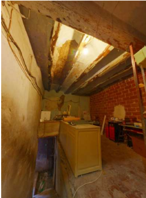
DF.17. Accés a l'antic forn de pa de la planta semi soterrada
