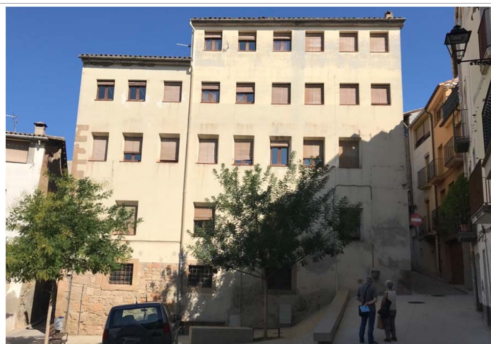
Escola municipal de música de Ponts – Façana a la plaça Portal nou
