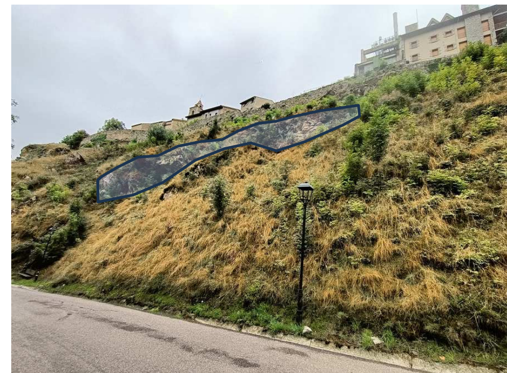
Figura 7: Espadat rocós a estabilitzar a la Zona 3 amb xarxes de cable
