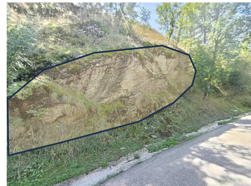
Figura 8: Espadats rocosos a estabilitzar a la Zona 3 amb malla de doble torsió
