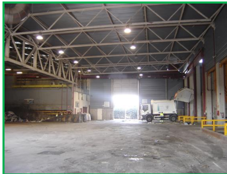
1. Zona de recepción y descarga de residuos
