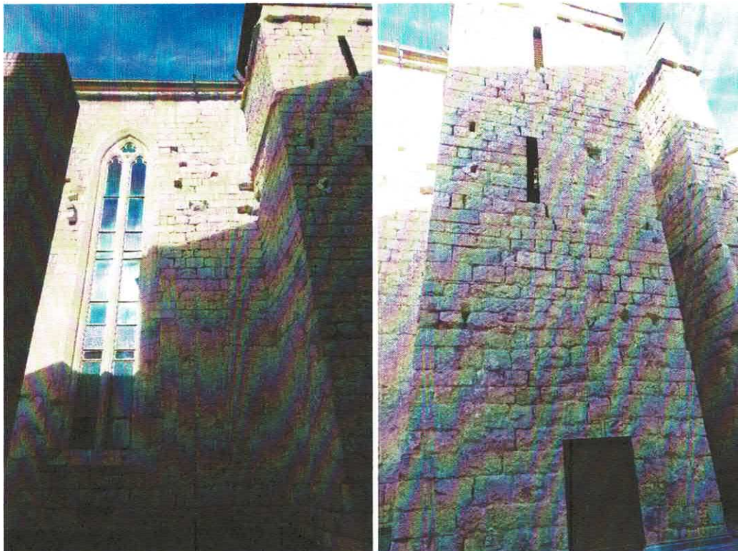
Tram de façana de la primera crugia i vista frontal de la caixa d'escala. Els vestigis de l'antic edifici de les latrines de la caserna resulten evidents
