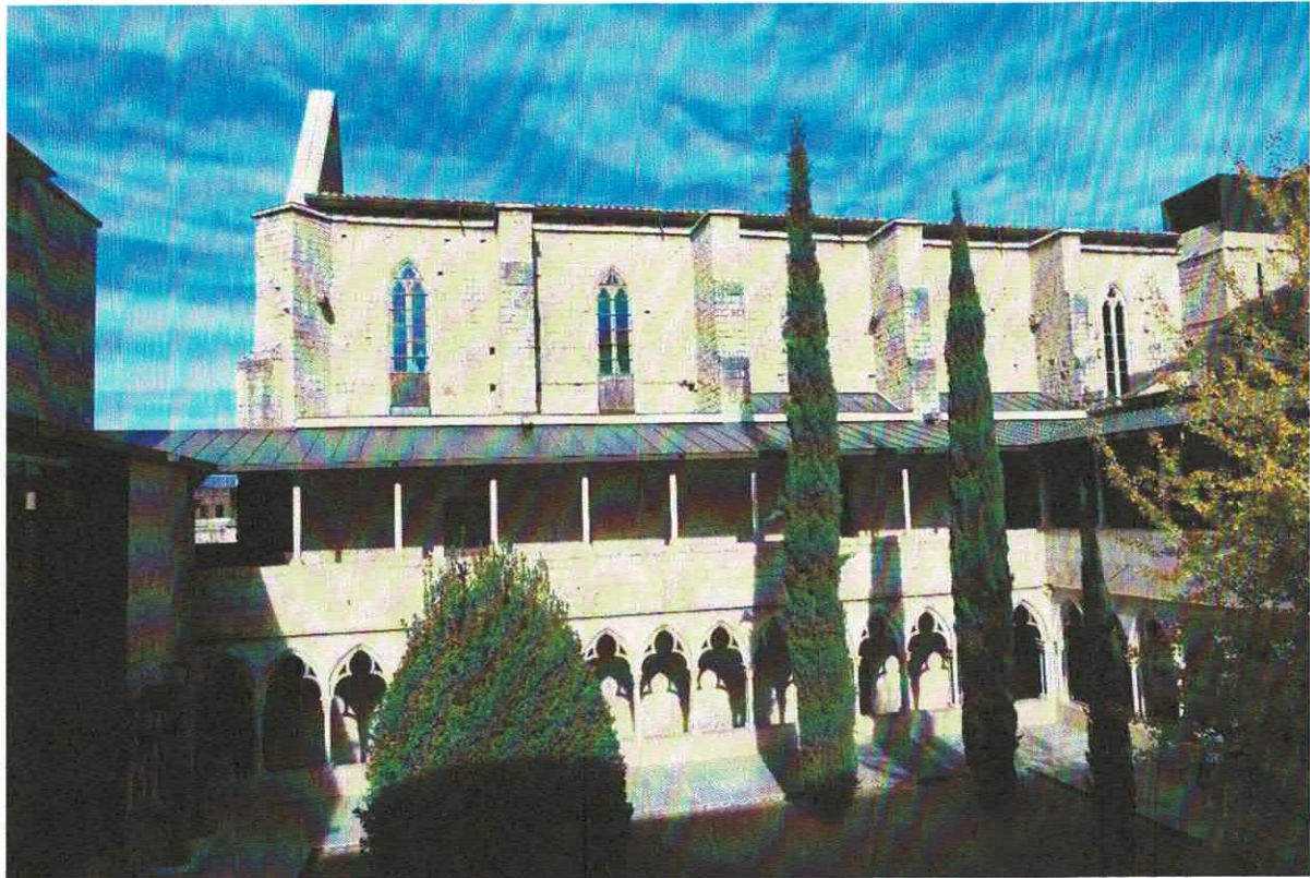
Vista general de la façana sud des del claustre.
