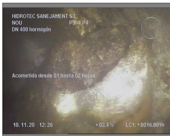
Foto: 7_10A, 00:05:38 16,8m, Acometida desde 01 hasta 02 horas
