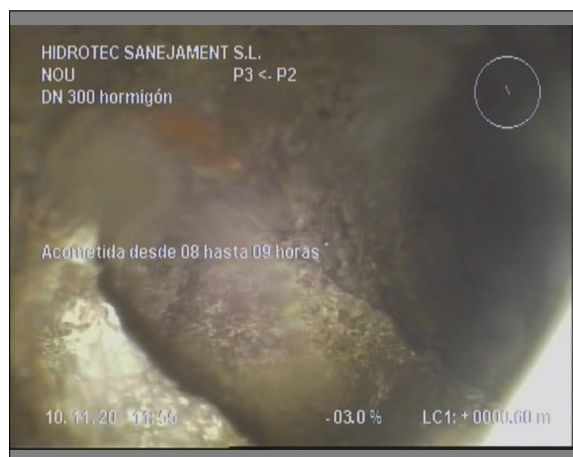
Foto: 6_2A, 00:00:24 0,6m, Acometida desde 08 hasta 09 horas
