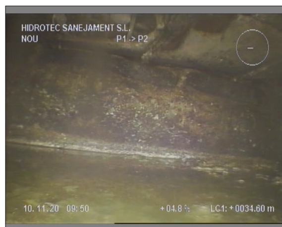
Foto: 2_10A, 00:09:47 34,6m, Acometida a las 07 horas
