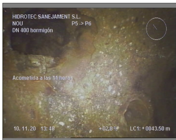
Foto: 9_13A, 00:09:24 43,5m, Acometida a las 11 horas
