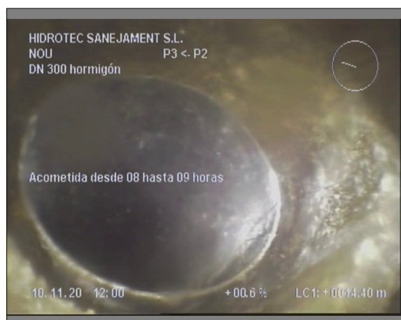
Foto: 6_7A, 00:04:21 14,4m, Acometida desde 08 hasta 09 horas
