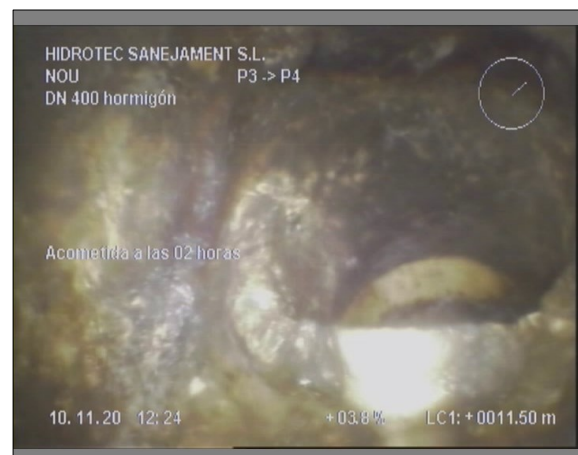
Foto: 7_7A, 00:04:06 11,5m, Acometida a las 02 horas
