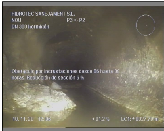
Foto: 6_14A, 00:08:36 27,7m, Obstáculo por incrustaciones desde 06 hasta 08 horas. Reducción de sección 6 %
