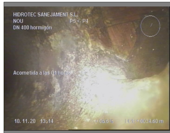
Foto: 8_11A, 00:09:10 34,6m, Acometida a las 01 horas
