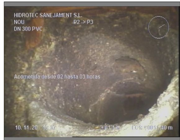
Foto: 4_7A, 00:05:10 11,4m, Acometida desde 02 hasta 03 horas
