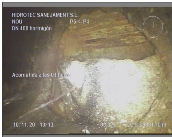
Foto: 8_10A, 00:08:28 31,7m, Acometida a las 01 horas
