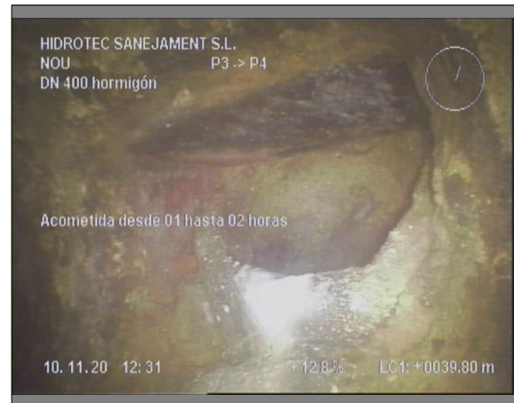
Foto: 7_17A, 00:09:53 39,8m, Acometida desde 01 hasta 02 horas
