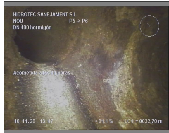
Foto: 9_12A, 00:08:09 32,7m, Acometida a las 11 horas
