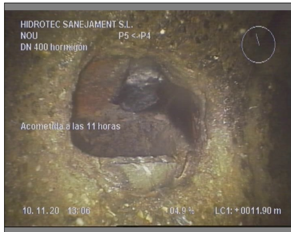
Foto: 8_3A, 00:02:42 11,9m, Acometida a las 11 horas
