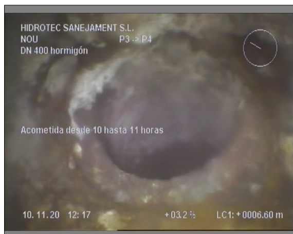
Foto: 7_5A, 00:01:41 6,6m, Acometida desde 10 hasta 11 horas
