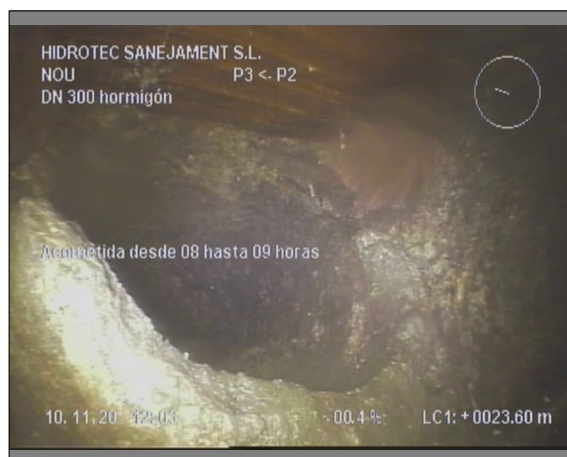
Foto: 6_11A, 00:06:42 23,6m, Acometida desde 08 hasta 09 horas
