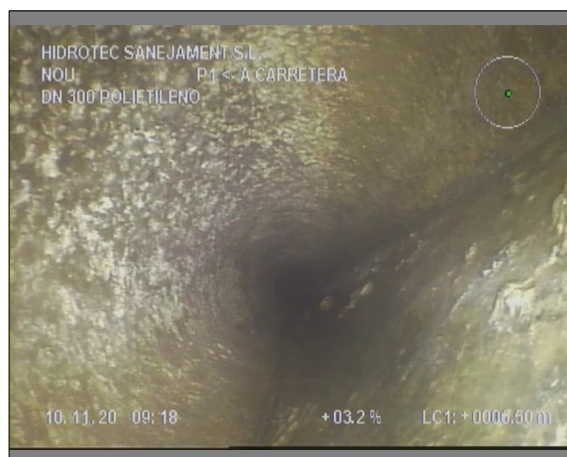
Foto: 1_3A, 00:01:34 6,5m, Obstáculo por sedimentaciones desde 05 hasta 07 horas. Reducción de sección 3 %
