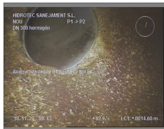
Foto: 2_5A, 00:03:39 14,6m, Acometida desde 01 hasta 02 horas
