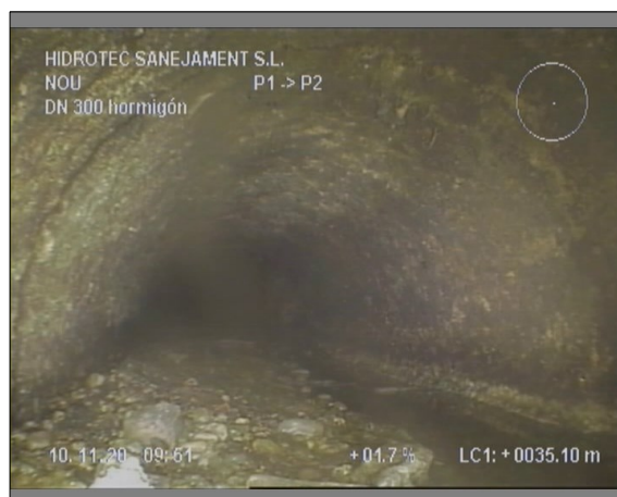
Foto: 2_11A, 00:10:36 35,1m, Obstáculo por sedimentaciones desde 05 hasta 07 horas. Reducción de sección 10 %
