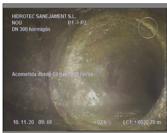
Foto: 2_9A, 00:08:42 32,7m, Acometida desde 04 hasta 05 horas
