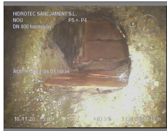
Foto: 8_4A, 00:03:54 12,4m, Acometida a las 01 horas
