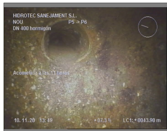
Foto: 9_14A, 00:09:57 43,9m, Acometida a las 11 horas
