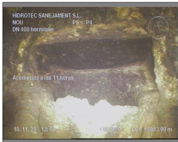
Foto: 8_5A, 00:04:26 13,9m, Acometida a las 11 horas
