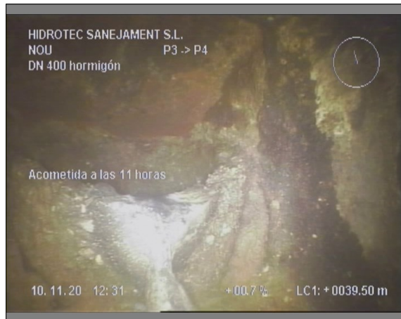
Foto: 7_16A, 00:09:31 39,5m, Acometida a las 11 horas
