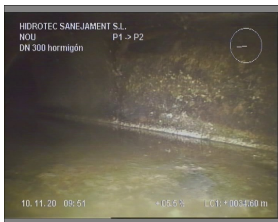
Foto: 2_10B, 00:09:47 34,6m, Acometida a las 07 horas
