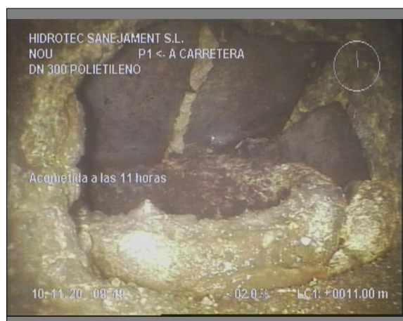
Foto: 1_4A, 00:02:33 11m, Acometida a las 11 horas
