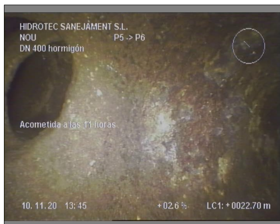
Foto: 9_9A, 00:06:35 22,7m, Acometida a las 11 horas
