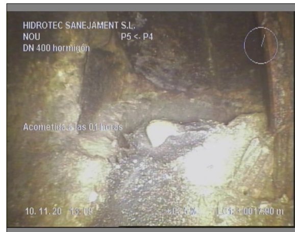
Foto: 8_6A, 00:05:18 17,9m, Acometida a las 01 horas
