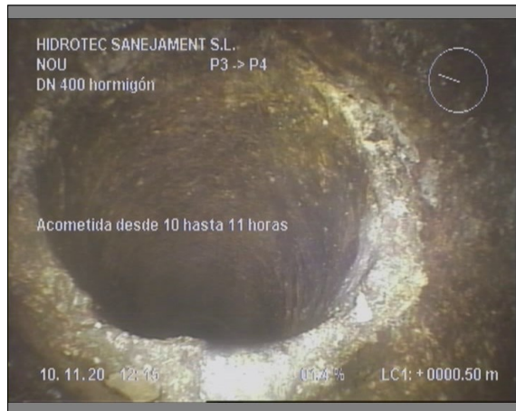
Foto: 7_2A, 00:00:21 0,5m, Acometida desde 10 hasta 11 horas
