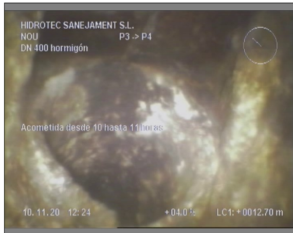
Foto: 7_8A, 00:04:34 12,7m, Acometida desde 10 hasta 11 horas
