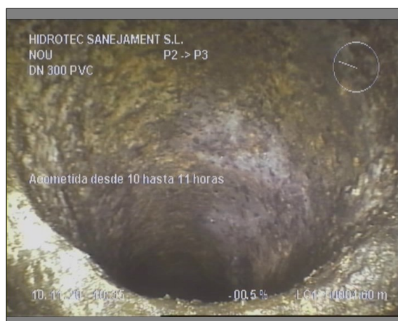
Foto: 4_5A, 00:03:01 4,6m, Acometida desde 10 hasta 11 horas
