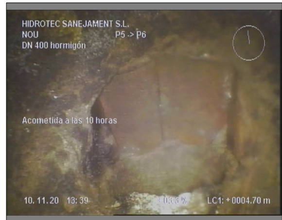
Foto: 9_3A, 00:01:39 4,7m, Acometida a las 10 horas
