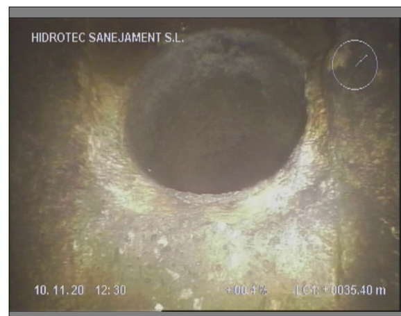
Foto: 7_15A, 00:08:49 35,4m, Acometida desde 01 hasta 02 horas
