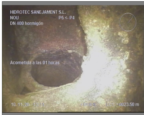
Foto: 8_8A, 00:06:40 23,5m, Acometida a las 01 horas
