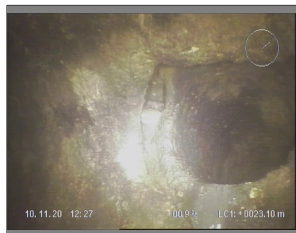
Foto: 7_11A, 00:06:31 23,1m, Acometida desde 01 hasta 02 horas
