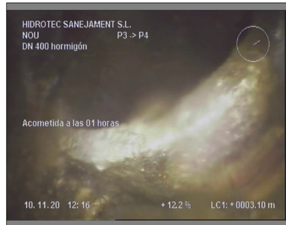
Foto: 7_4A, 00:01:04 3,1m, Acometida a las 01 horas
