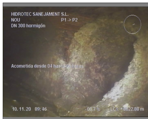
Foto: 2_7A, 00:06:05 22,8m, Acometida desde 04 hasta 05 horas
