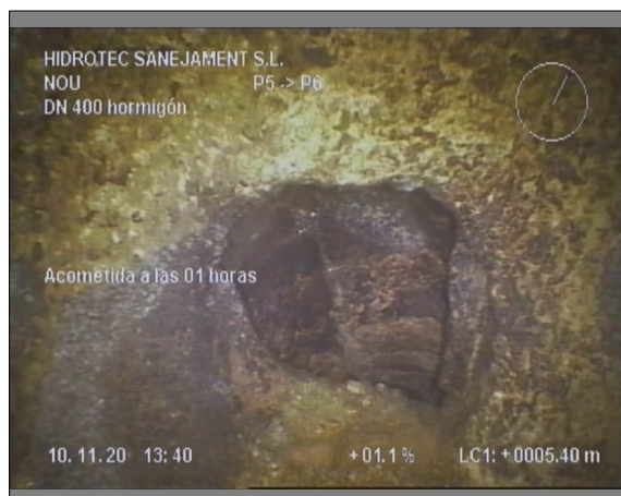
Foto: 9_4A, 00:02:10 5,4m, Acometida a las 01 horas
