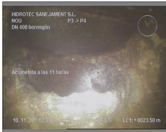
Foto: 7_12A, 00:06:57 23,5m, Acometida a las 11 horas
