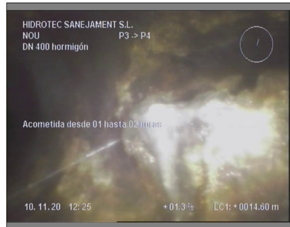
Foto: 7_9A, 00:05:04 14,6m, Acometida desde 01 hasta 02 horas
