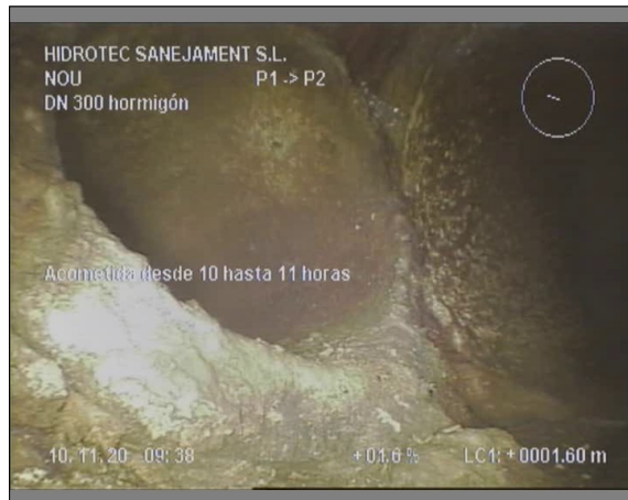
Foto: 2_2A, 00:00:36 1,6m, Acometida desde 10 hasta 11 horas
