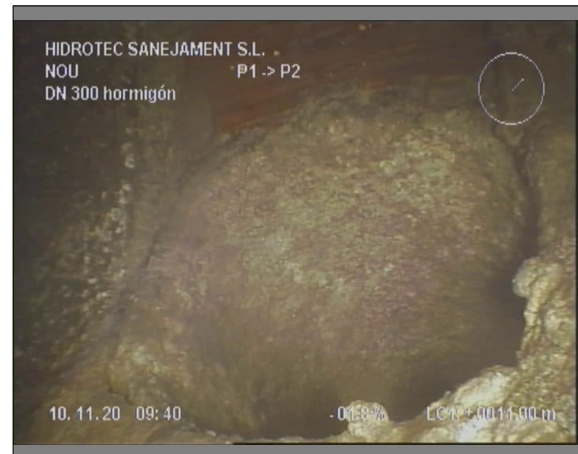
Foto: 2_3A, 00:01:58 11m, Acometida desde 01 hasta 02 horas
