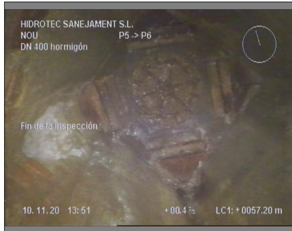
Foto: 9_15A, 00:11:38 57,2m, Fin de la inspección
