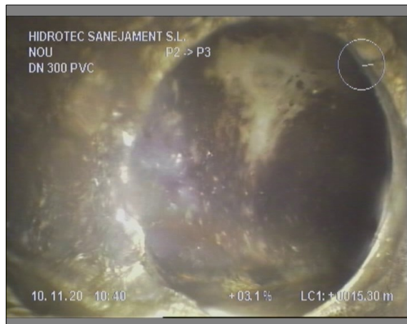
Foto: 4_8A, 00:07:17 15,3m, Acometida desde 03 hasta 04 horas
