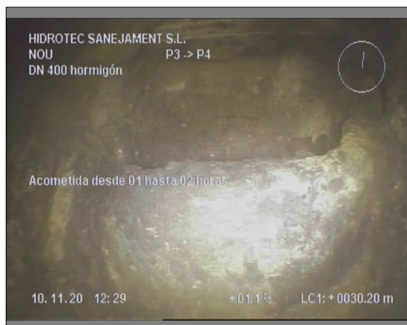
Foto: 7_14A, 00:08:08 30,2m, Acometida desde 01 hasta 02 horas
