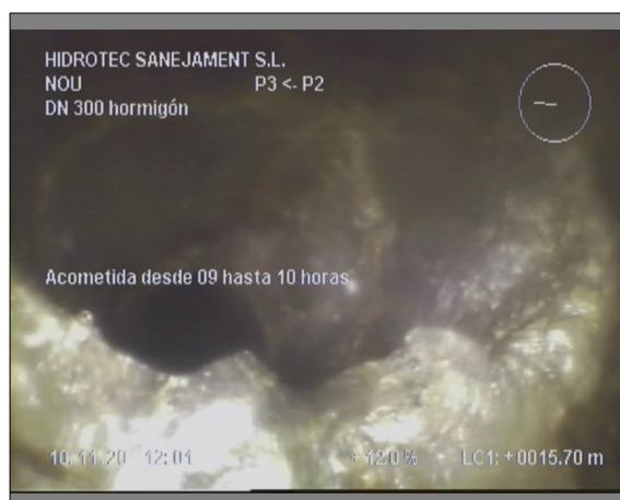
Foto: 6_8A, 00:04:54 15,7m, Acometida desde 09 hasta 10 horas
