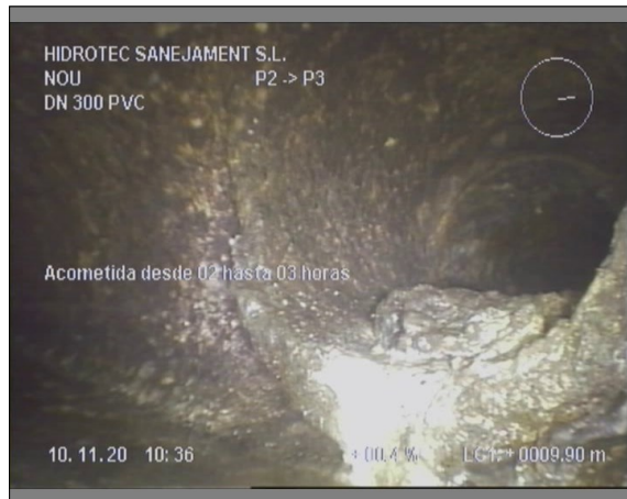
Foto: 4_6A, 00:04:31 9,9m, Acometida desde 02 hasta 03 horas
