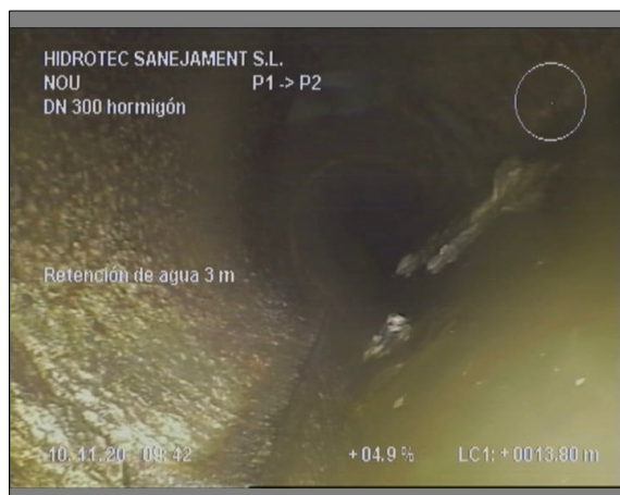
Foto: 2_4A, 00:02:58 13,8m, Retención de agua 3 m
