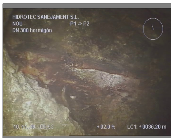
Foto: 2_13A, 00:11:39 36,2m, Deformación desde 11 hasta 01 horas. Reducción de 30 mm
