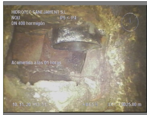
Foto: 8_9A, 00:07:19 25,8m, Acometida a las 01 horas
