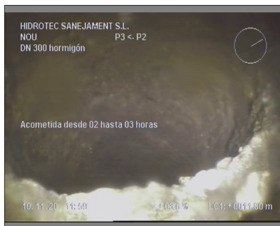
Foto: 6_6A, 00:03:38 11,8m, Acometida desde 02 hasta 03 horas
