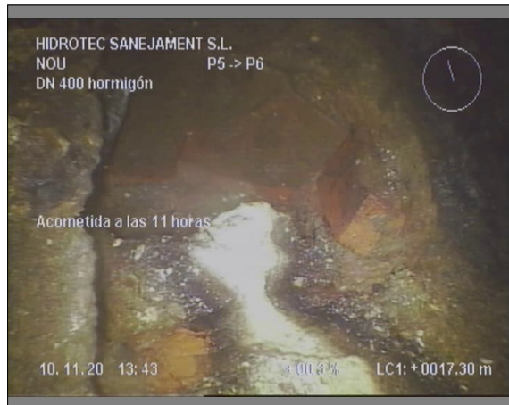
Foto: 9_6A, 00:05:20 17,3m, Acometida a las 11 horas
