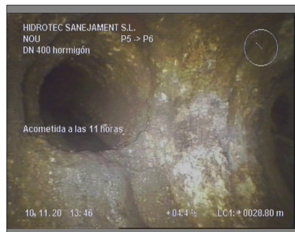
Foto: 9_10A, 00:07:15 28,8m, Acometida a las 11 horas
