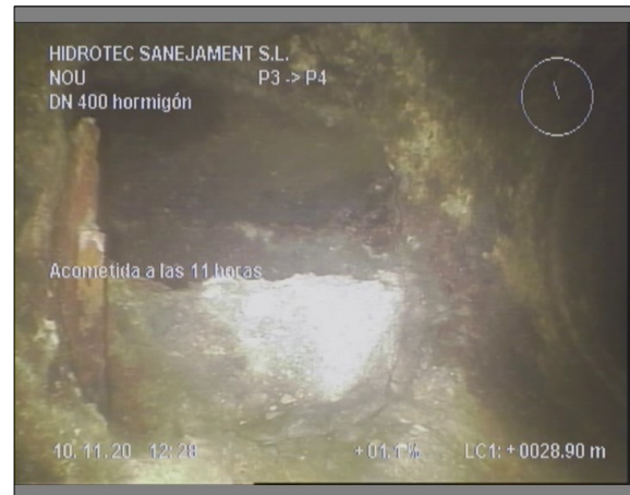
Foto: 7_13A, 00:07:40 28,9m, Acometida a las 11 horas
