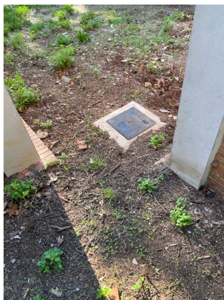
Arqueta existent aigua potable
