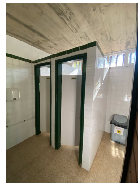
interior Mòdul B
