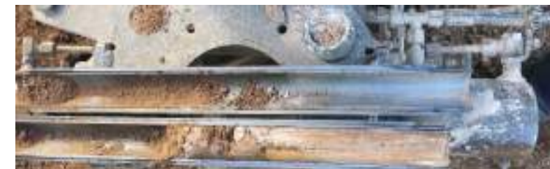
Fotografia 7 i 8. Emplaçament del S-4 i assaig SPT a -1,5m.
