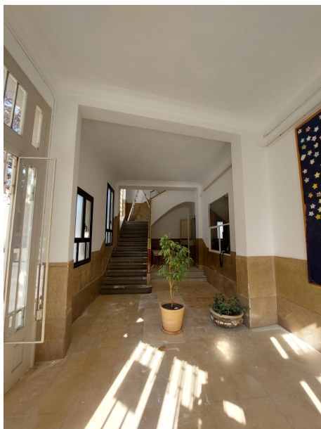
Vista general del vestíbul del centre on s'ha de substituir el paviment per tal d'unificar-lo
