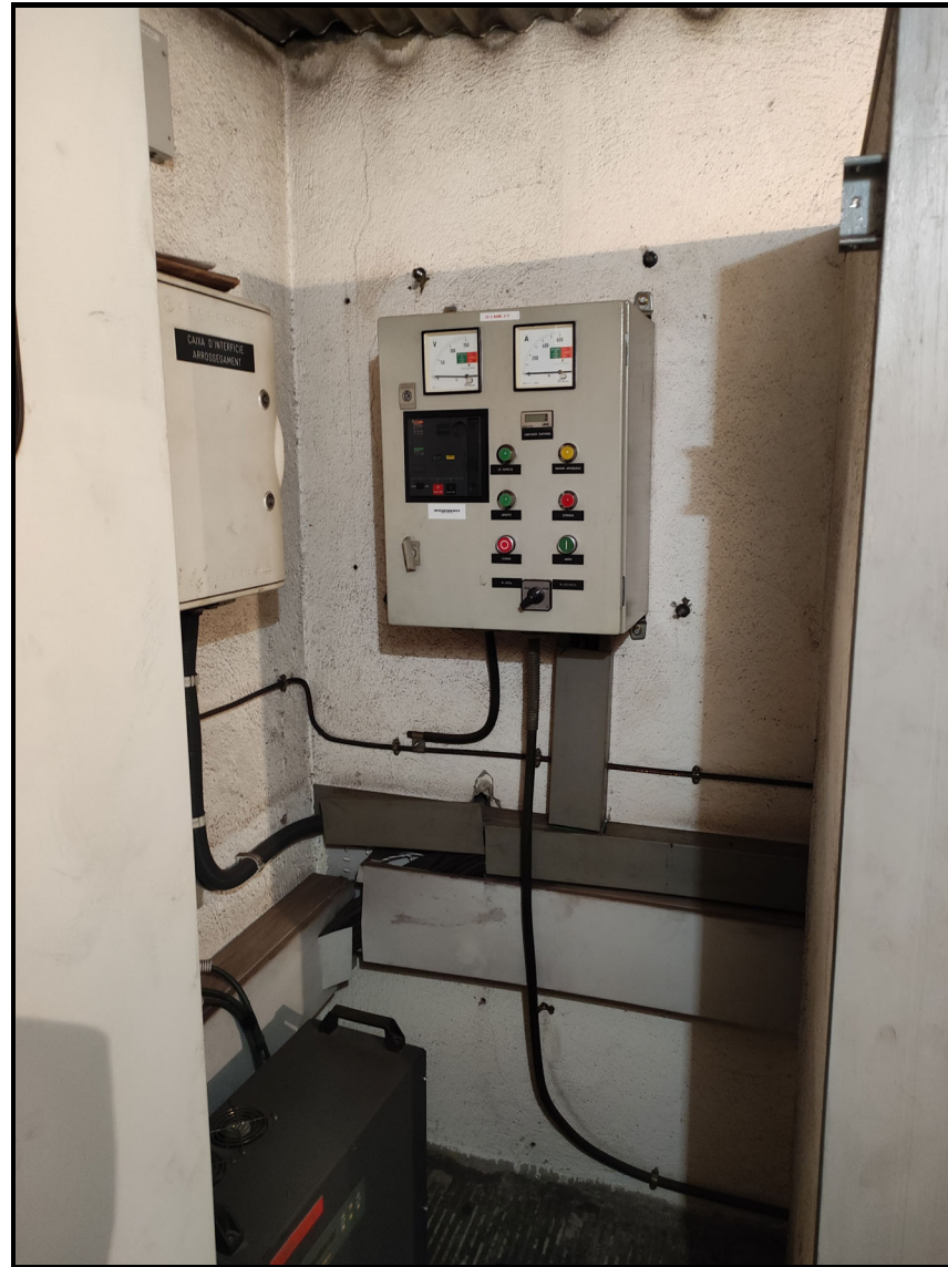
Equip VLD actual a substituir
