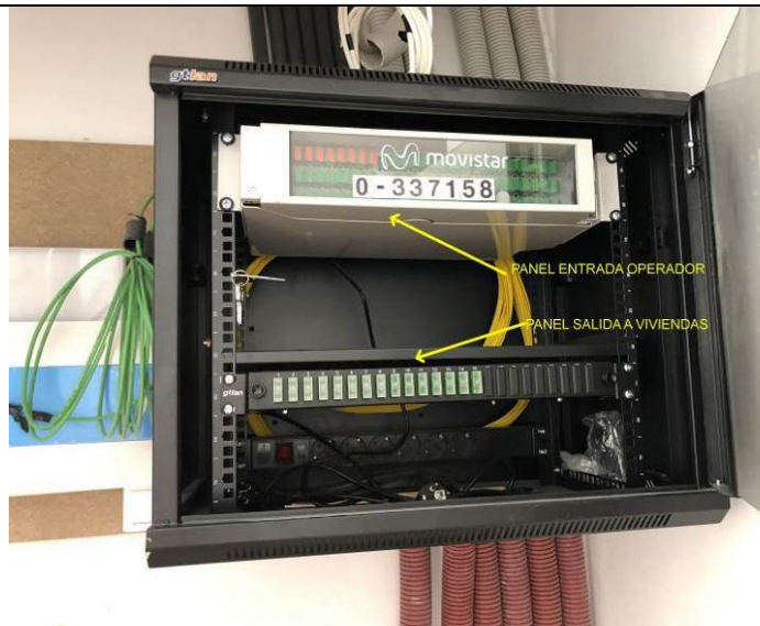
FOTO EJEMPLO NO CONTRACTUAL INSTALACION PANEL CONECTOR DE SALIDA FIBRA OPTICA MEDIANTE RACK 19 PERFILES NORMALIZADOS ETSI. ESCENARIO >20PAU (en este caso telefónica finaliza con paneles normalizados etsi en la parte inferior del rack) (la foto no cumple con la prescripción de telefónica referente a que los paneles de salida deben estar situados arriba del armario)
