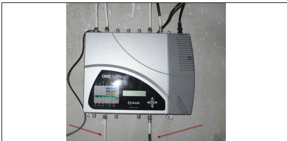
El propio amplificador IKUSI ONE+SAT 2dd Ready (o SIMILAR) realiza los 2 ramales necesarios en la instalación. Foto similar no contractual.
