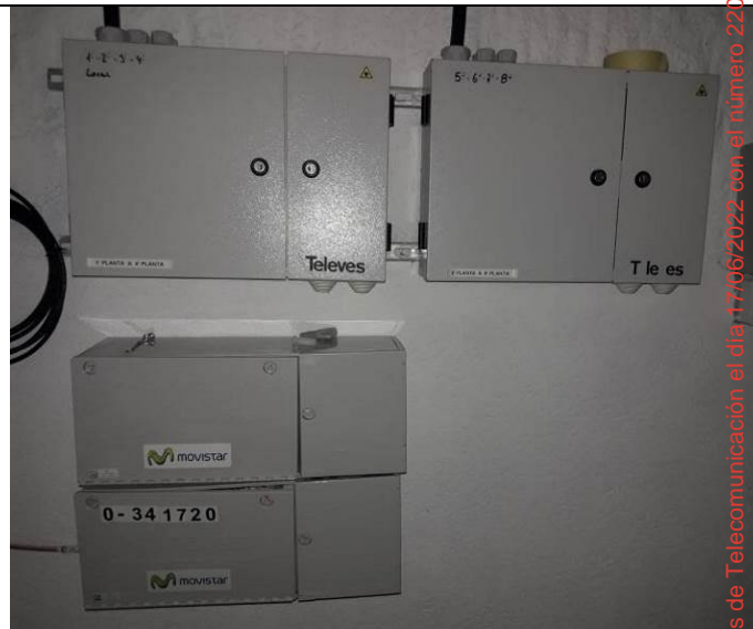
FOTO EJEMPLO INSTALACION PANEL CONECTOR DE SALIDA FIBRA OPTICA MEDIANTE REGISTRO CAJA TELEVES. ESCENARIO <20PAU (en este caso telefónica finaliza con una caja del tipo MBI48)
