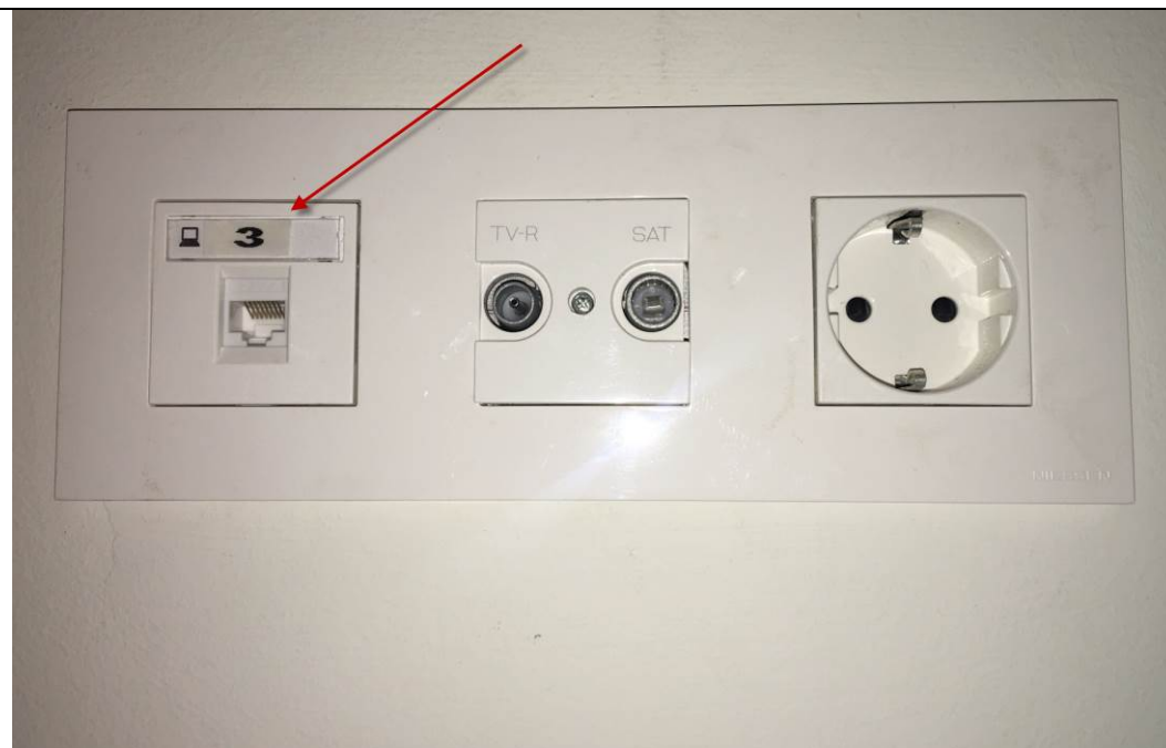
Etiquetado cableado UTP en el RTR
