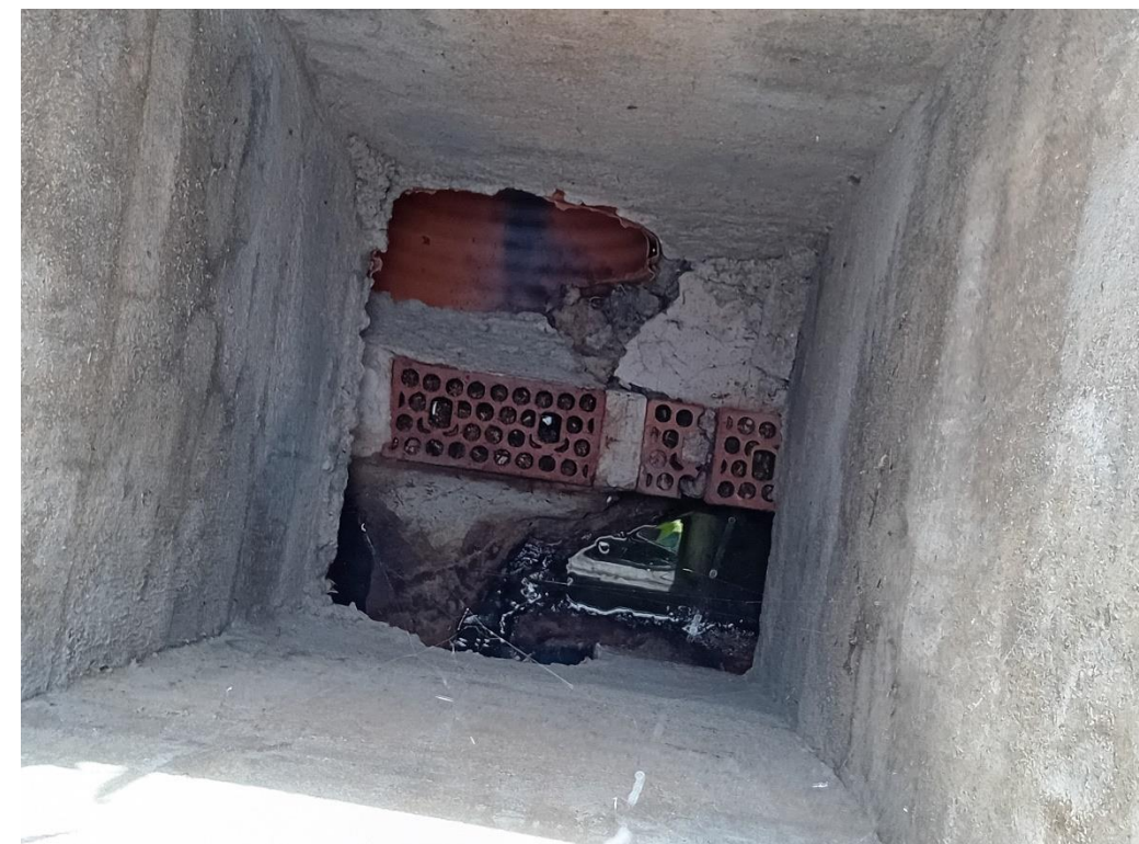
Fotografia 3. Interior del pou sobreeixidor
