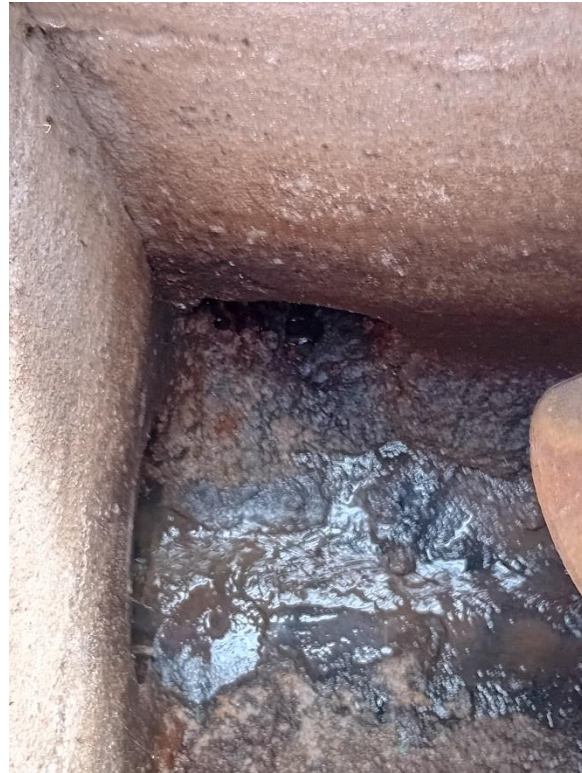
Fotografia 8. Connexió amb pou pluvial
