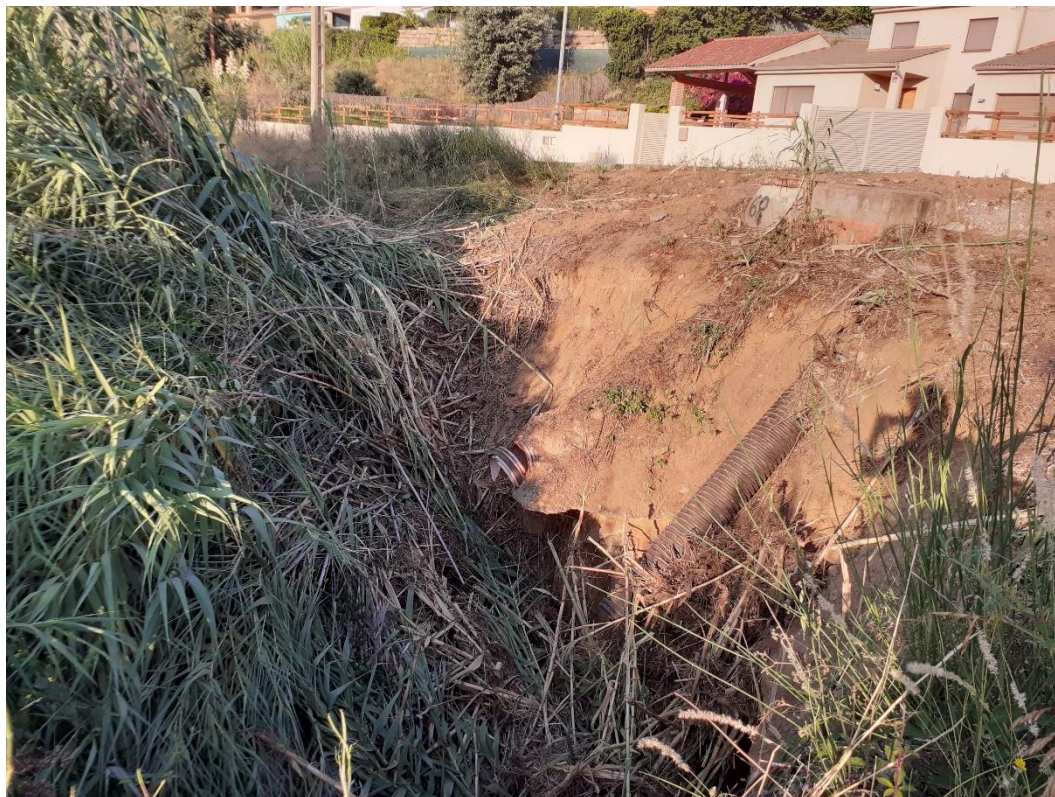
Fotografia 13. Pous del col·lector en alta i sobreixidor
