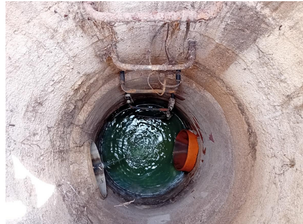
Fotografia 2. Interior del pou del col·lector en alta
