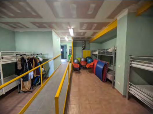
Vista 1: Rampa de l'habitació de l'alberg
