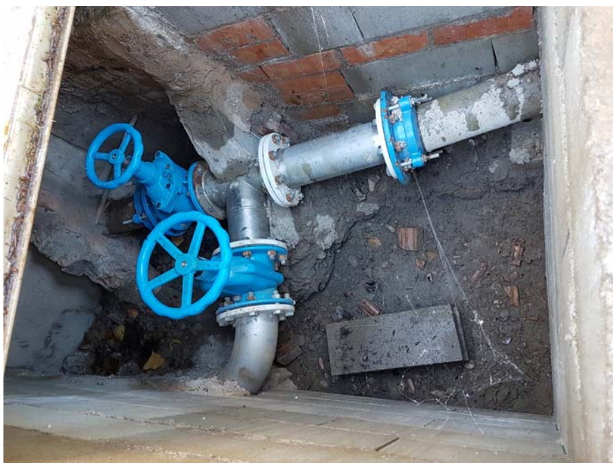
Imatge núm. 1b. Interior de l'arqueta fora del pou de Vernetot on es veu l'arribada de les dues canonades dels pous (pou nou i pou Vernetot) i l'inici de la canonada de fibrociment D125 que puja al dipòsit de Cooperativa.
