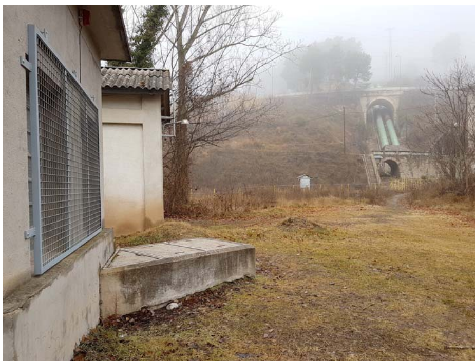
Imatge núm. 1a. Situació de l'arqueta de sortida al costat del pou de Vernetot
