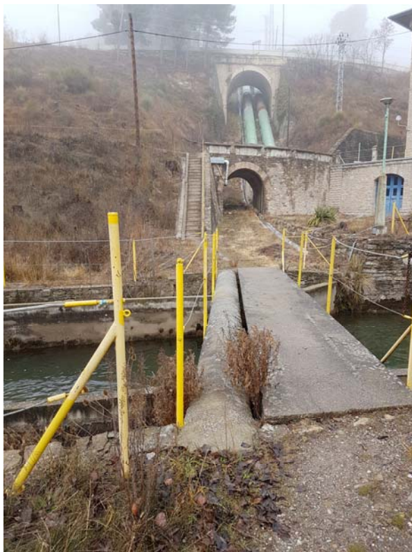
Imatge núm. 2. Visible el pas de la canonada que travessa el canal i segueix fins a la carretera.
