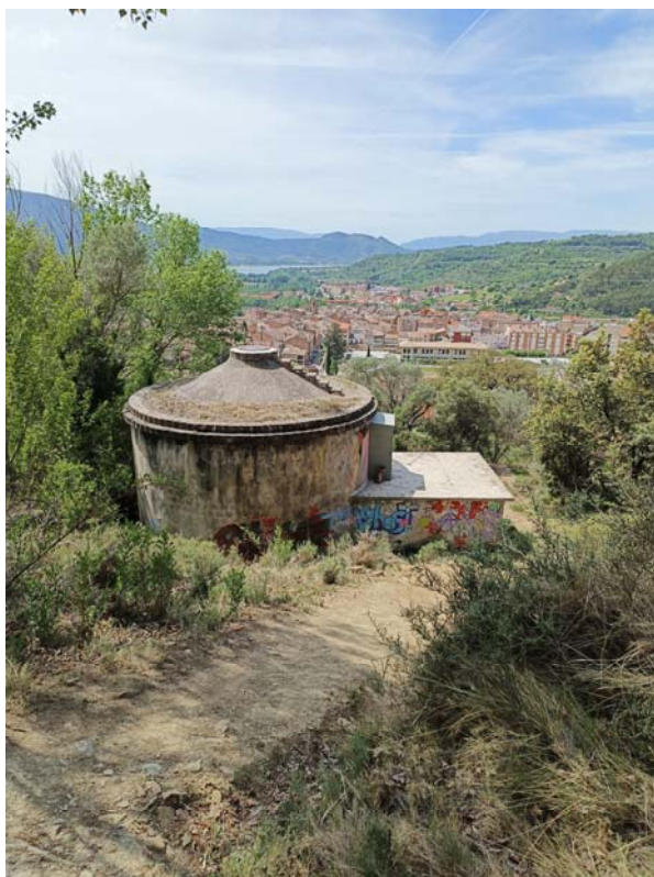
Imatge núm. 3. Visible el pas de la canonada que travessa el canal i segueix fins a la carretera.
