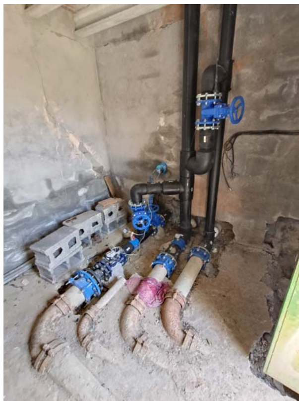
Imatge núm. 6. Válvules existents dipòsit Cooperativa. Esquema en plànol nº 14.
