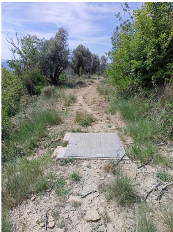
Imatge núm. 4. Traçat pel camí amb rasa al costat de la séquia existent.
