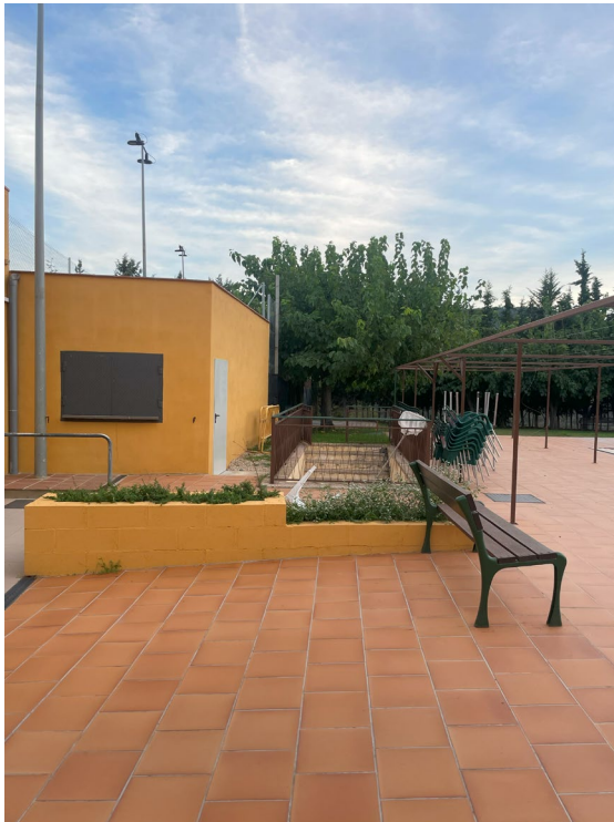
5. Edifici del bar i escales de baixada a les instal·lacions de la piscina.
