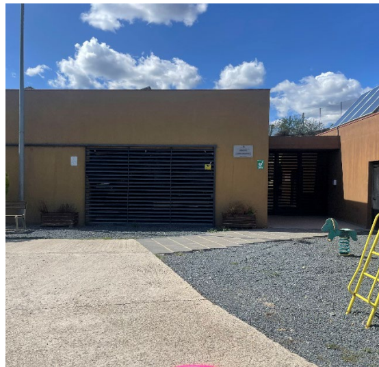
2. Edifici de les instal·lacions.
