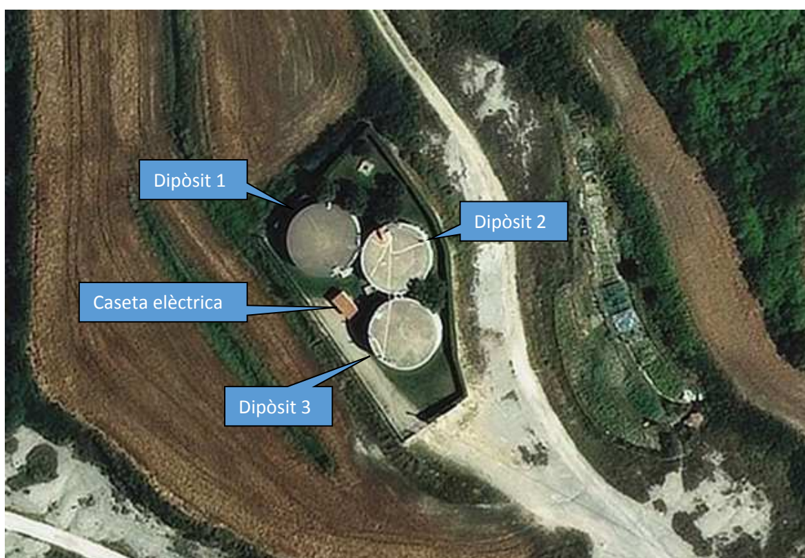
Imatge 1. Dipòsits del Pla de l'Aire
