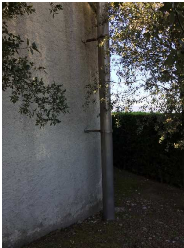
Foto 4. Canonada d'entrada al dipòsit 1
