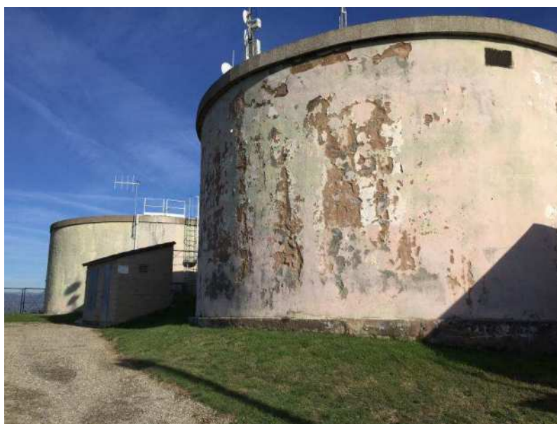
Fotografia 2. Vista dels dipòsits 1 i 3..
