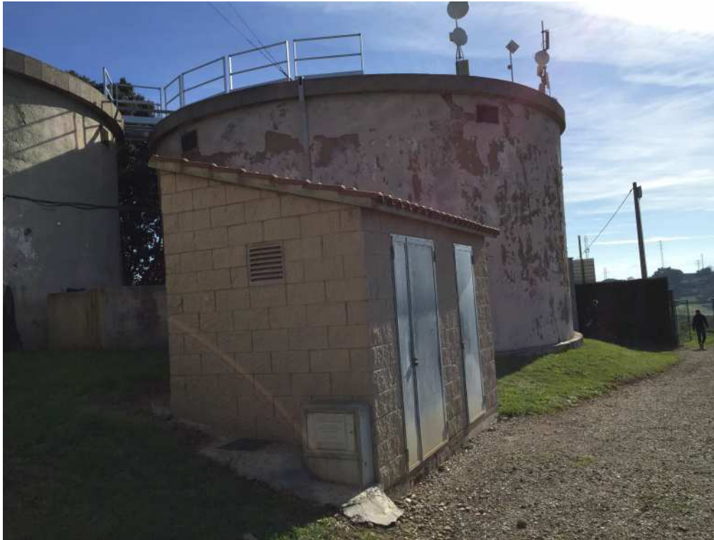
Foto 3. Caseta d'equips elèctrics
