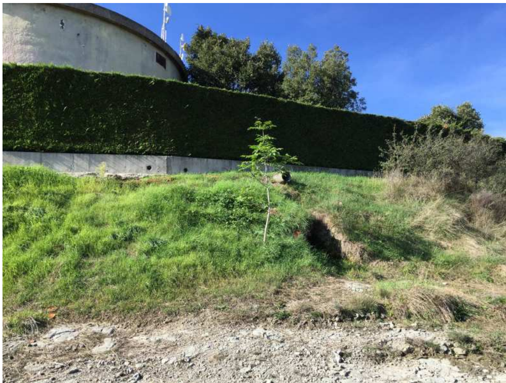
Foto 11. Vista del tancament des de l'exterior de la zona est i sortida tub de buidats.
