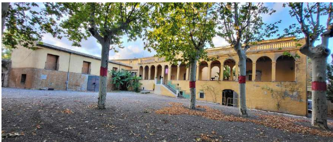
Vista des de l'interior del pati
