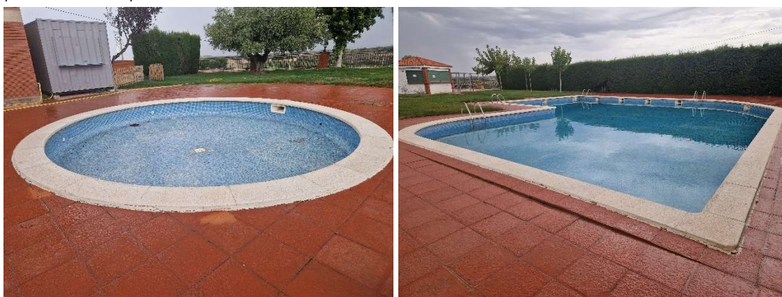
Imatge 4. Estat actual de les piscines.
