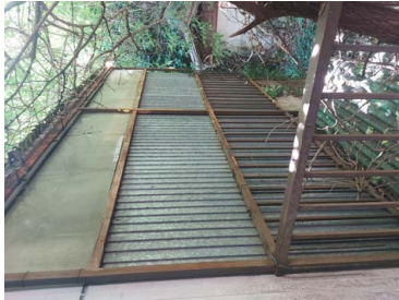
Hi ha una petita part del sostre d'aquesta planta esfondrat degut a l'entrada d'aigua, per l'esfondrament de part de la coberta de la planta primera.
