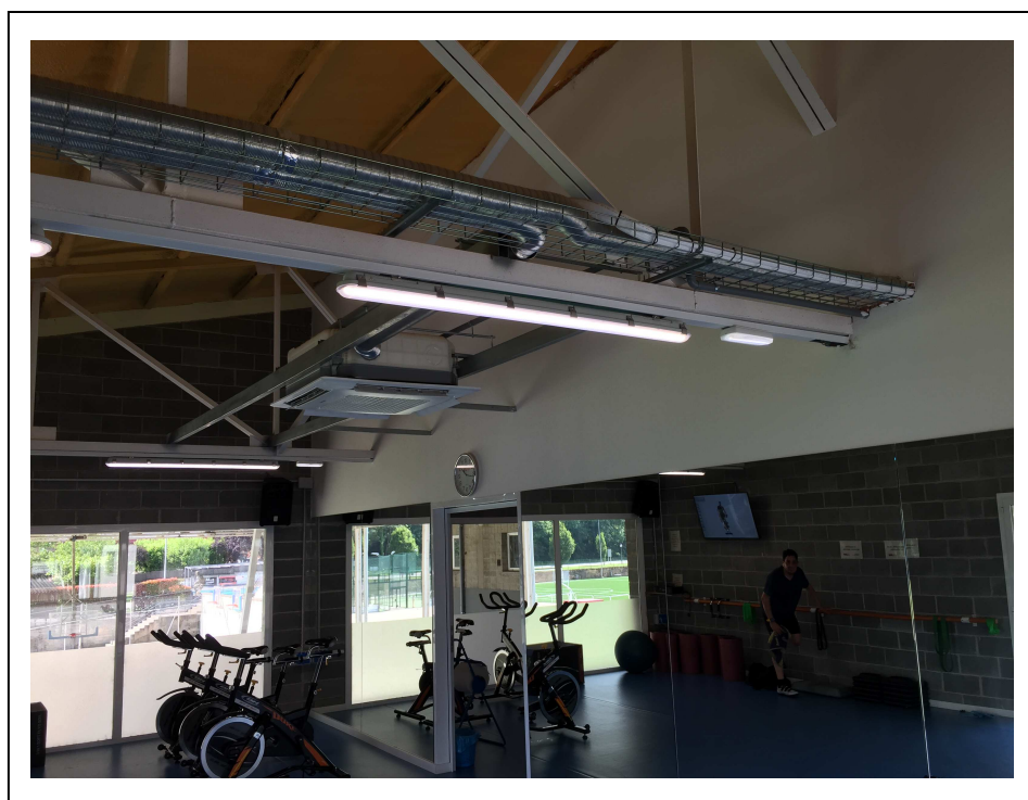
Foto 7. Paret de pladur existent a enderrocar.
