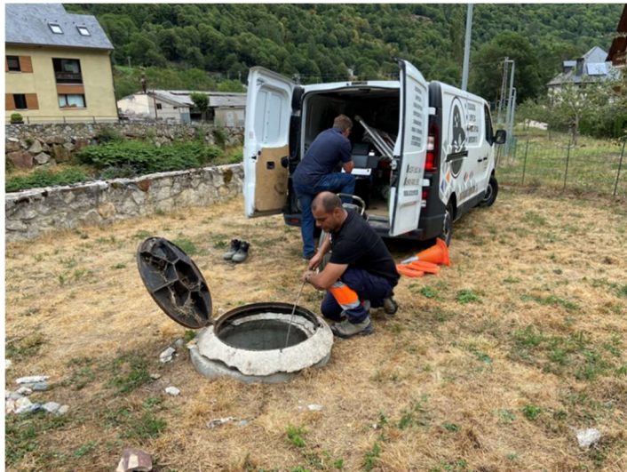
Imatge 5. Pou final del tram a encamisar
