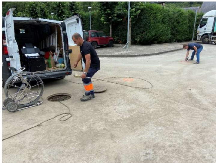
Imatge 3. Treballs fets d'inspecció de amb CCTV
