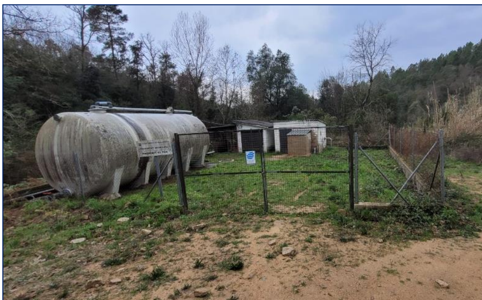
Il·lustració 13. Instal·lacions Can Fornaca. Dipòsit caseta, cloració.
