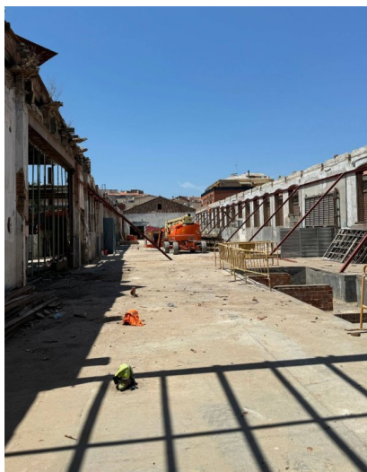
Desmuntatge de teules i de les encavallades
