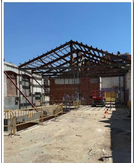
Desmuntatge de teules i de les encavallades
