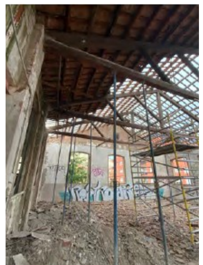
Desmuntatge de teules i de les encavallades
