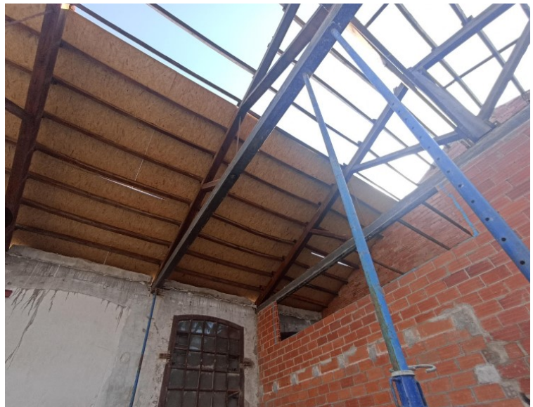
Cobriment de teulada amb pannels de fusta
