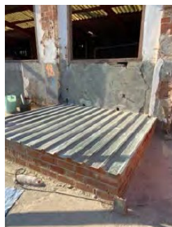
Treballs reforços pilastres i murets i protecció de forats
