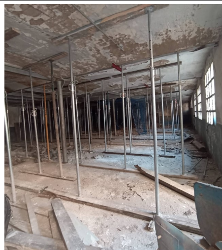
Reforç /reapuntament del soterrani
