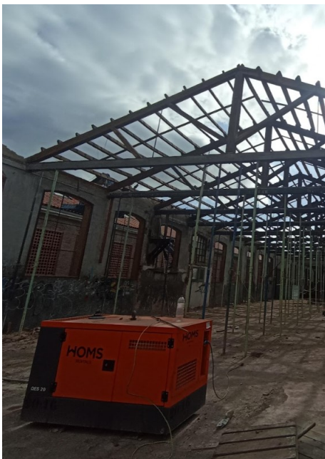
Treballs inicials de neteja i reapuntaments i desmuntatge de teules
