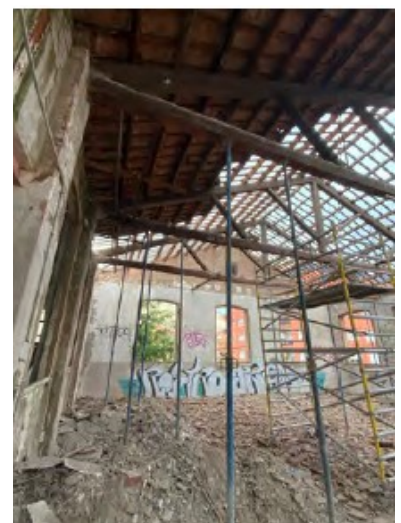
Desmuntatge de teules i de les encavallades
