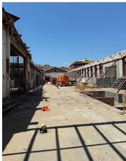
Desmuntatge de teules i de les encavallades
