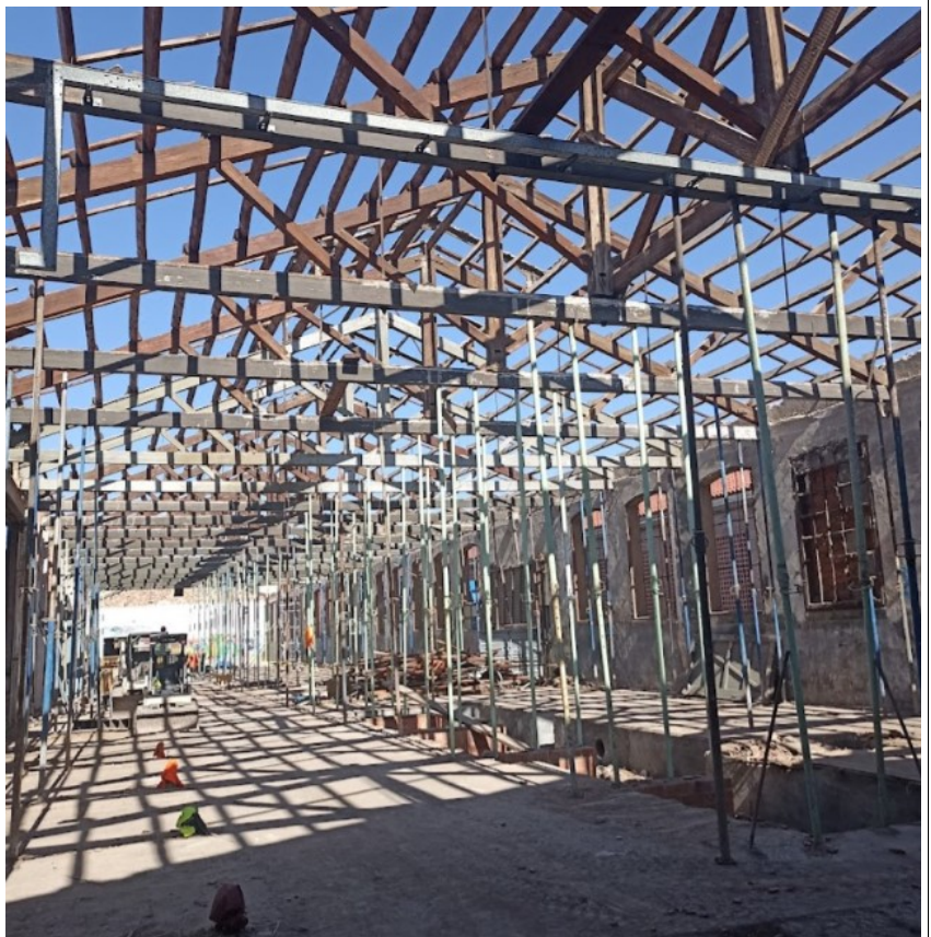
Treballs inicials de neteja i reapuntaments i desmuntatge de teules
