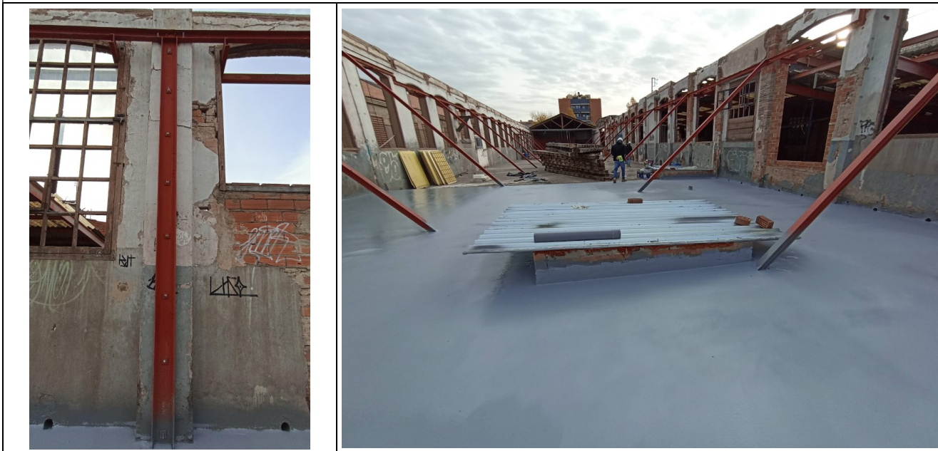
Treballs impermeabilització sostre soterrani
