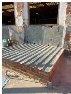
Treballs reforços pilastres i murets i protecció de forats
