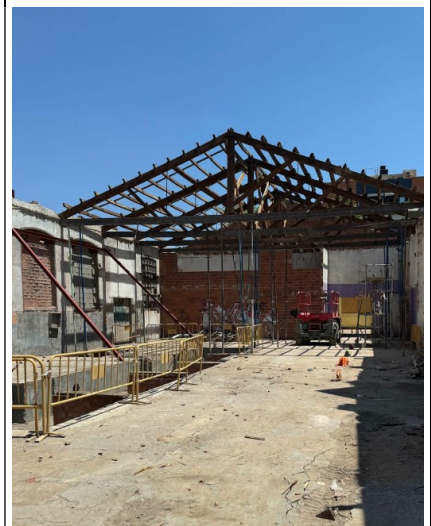
Desmuntatge de teules i de les encavallades
