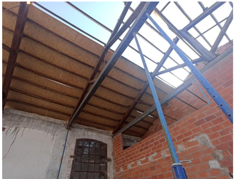
Cobriment de teulada amb pannels de fusta
