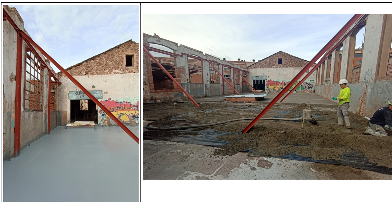
Treballs impermeabilització sostre soterrani
