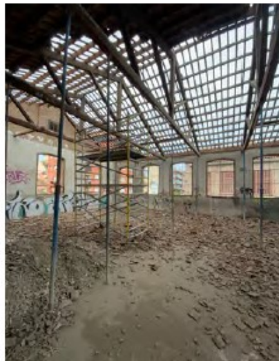
Desmuntatge de teules i de les encavallades
