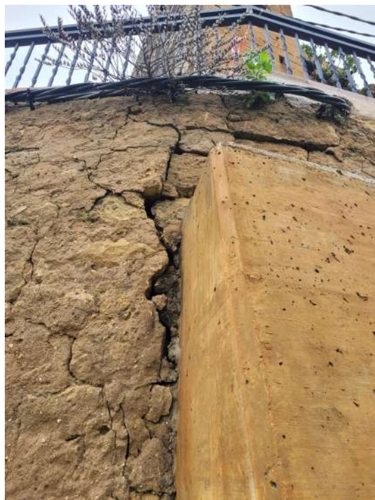
Zona a rehabilitar
