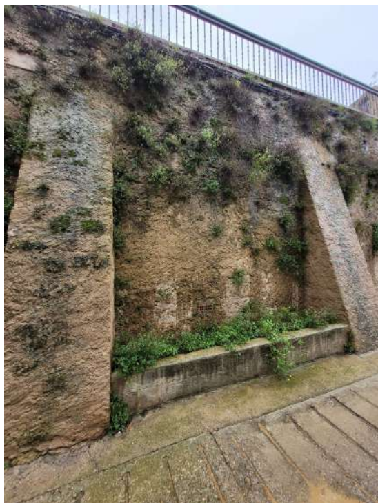
Tram 8 (reforç amb contrafort i consolidació)
