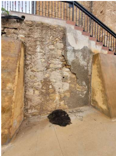
Tram 1 (reforç amb biga i consolidació)
