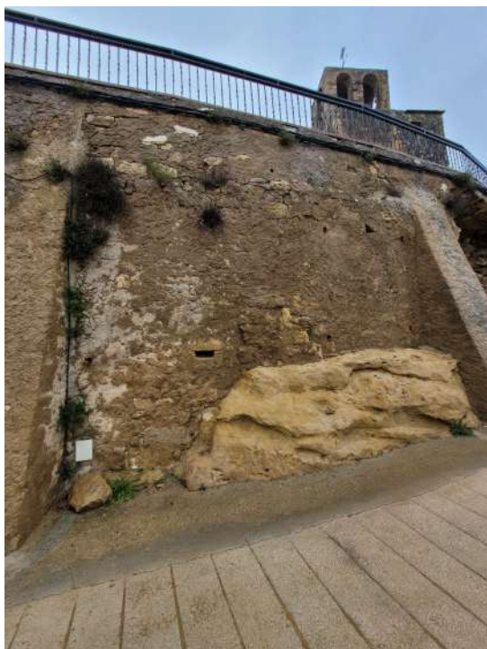
Tram 5 (reforç amb contrafort i consolidació)
