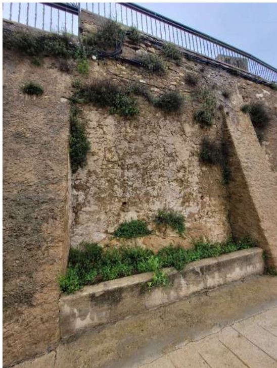
Tram 6 (reforç amb contrafort i consolidació)
