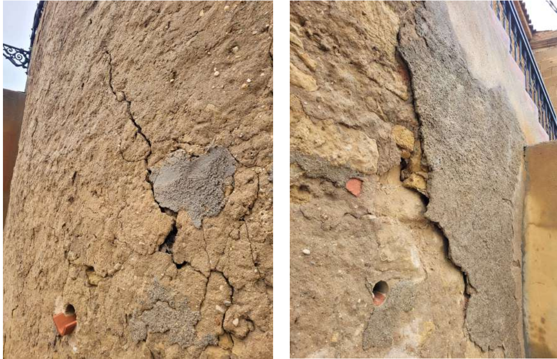
Estat dels paraments del mur de maçoneria de pedra (repicat del revestiment i neteja del parament)
