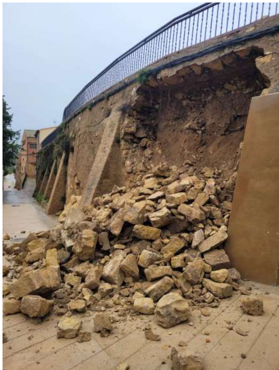
Tram 4, mur ensorrat (reconstrucció, reforç i consolidació)
