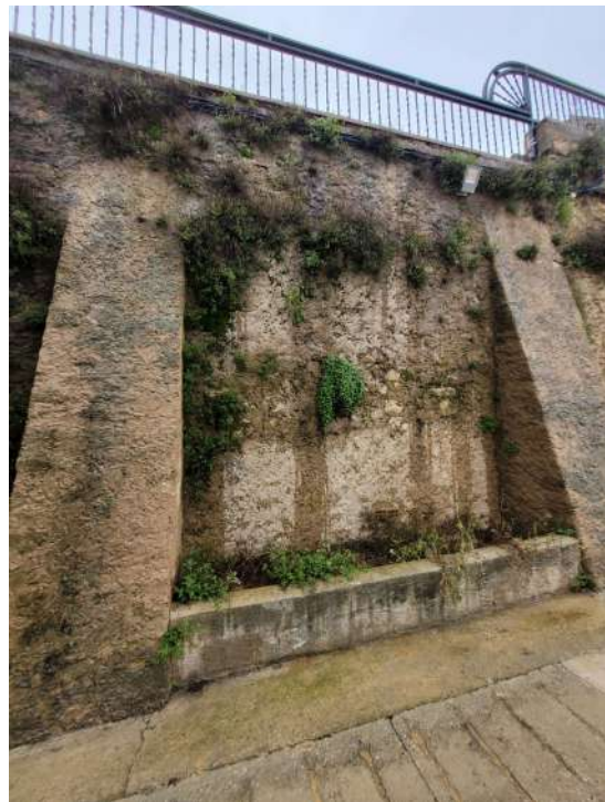
Tram 7 (reforç amb contrafort i consolidació)
