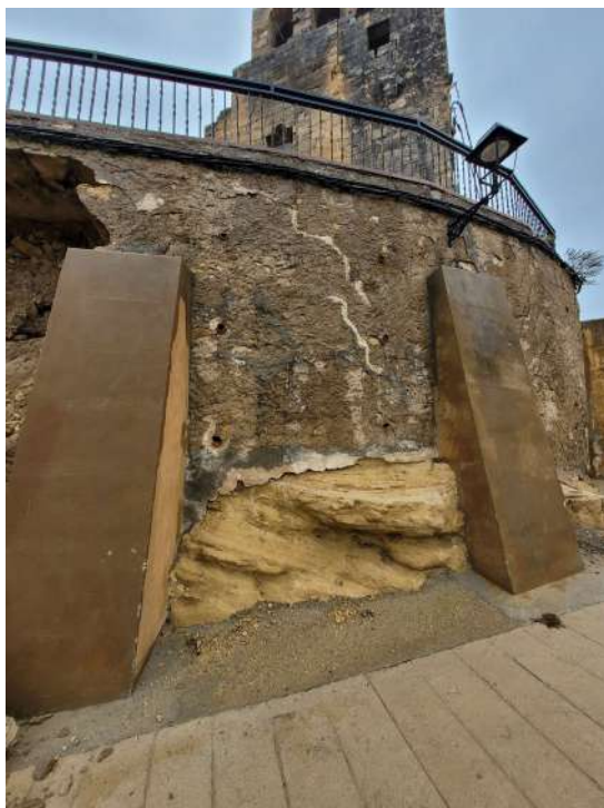
Tram 3 (reforç amb biga i consolidació)
