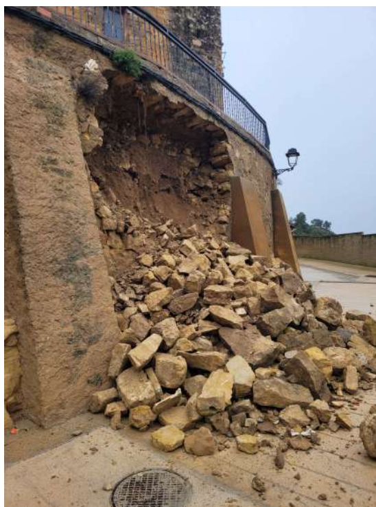
Tram 4, mur ensorrat (reconstrucció, reforç i consolidació)
