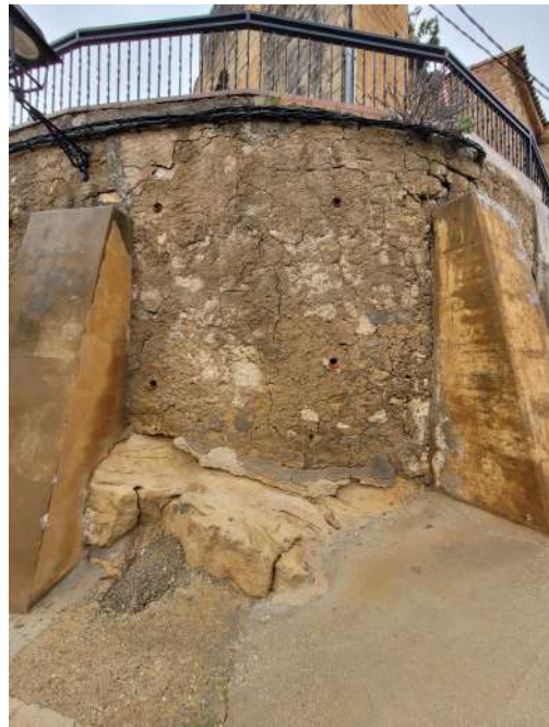
Tram 2 (reforç amb biga i consolidació)
