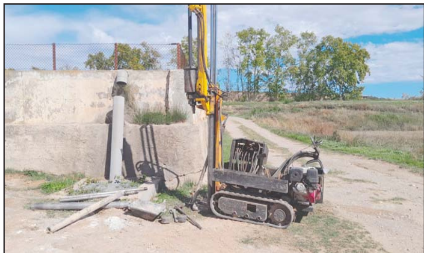
Fotografia 1. Vista de l'emplaçament de la màquina per a la realització del sondeig a rotació amb bateria continua S-1.
