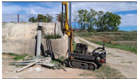
Fotografia 2. Vista de la màquina utilitzada per a la realització del sondeig a rotació S-1.
