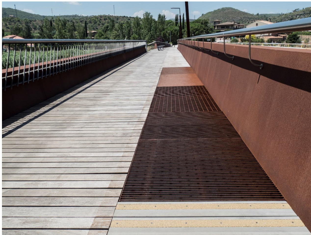
Imatge 2: Banc de proves amb diversos materials a l'any 2018
