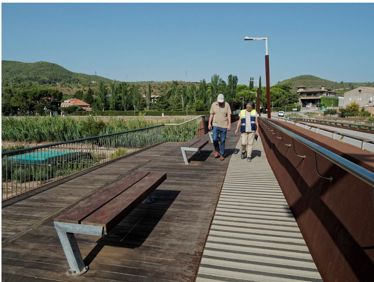
Imatge 4. Franja de tarima antilliscant instal·lada a l'any 2019
