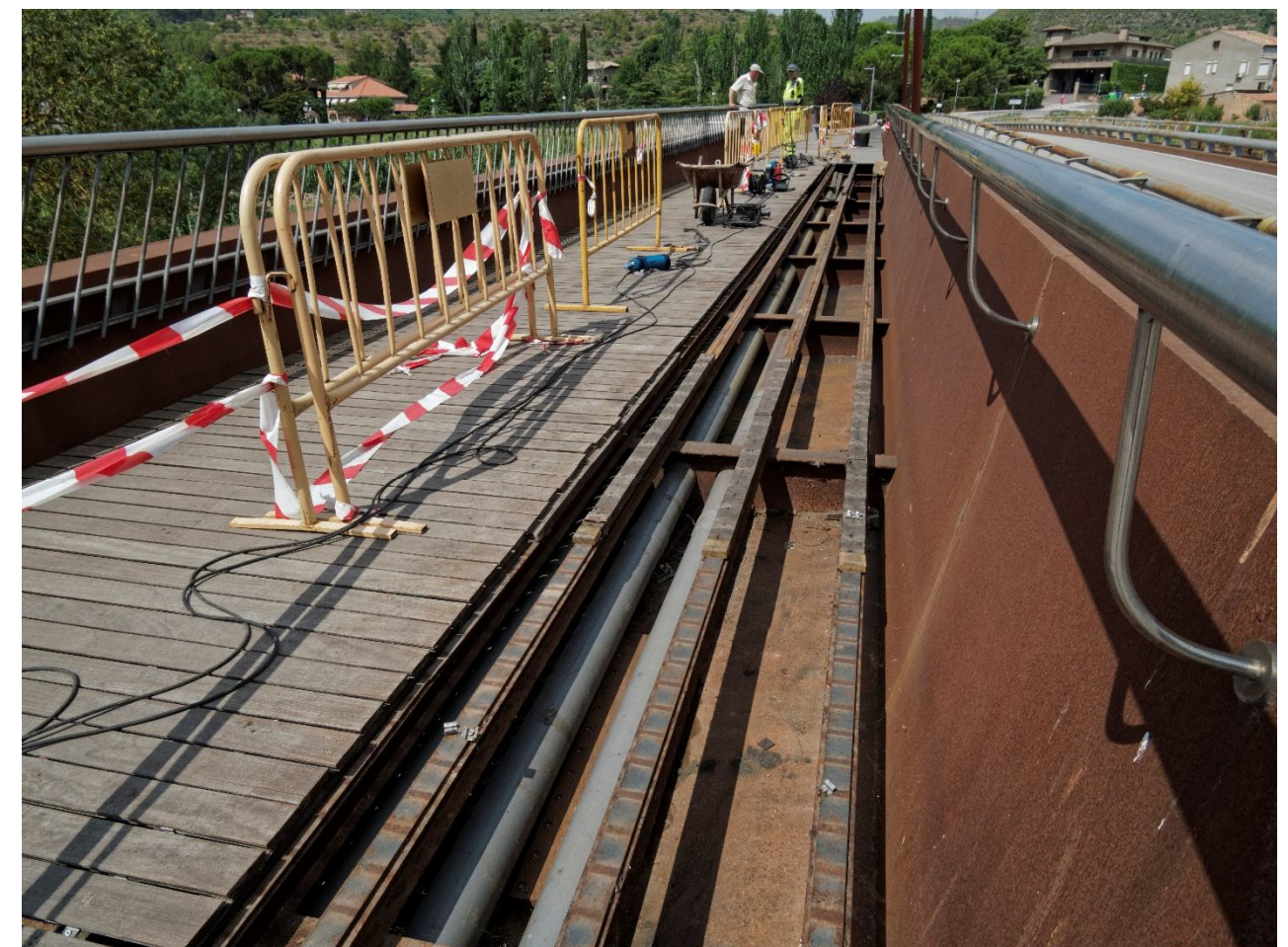
Imatge 3. Tasques de substitució de la tarima d'IPE per fusta sintètica amb banda abrasiva incorporada en una franja d'un metre d'amplada
