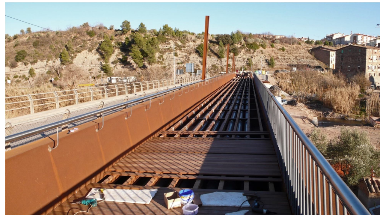
Imatge 1: Instal·lació de la tarima de fusta d'ipe a l'any 2007
