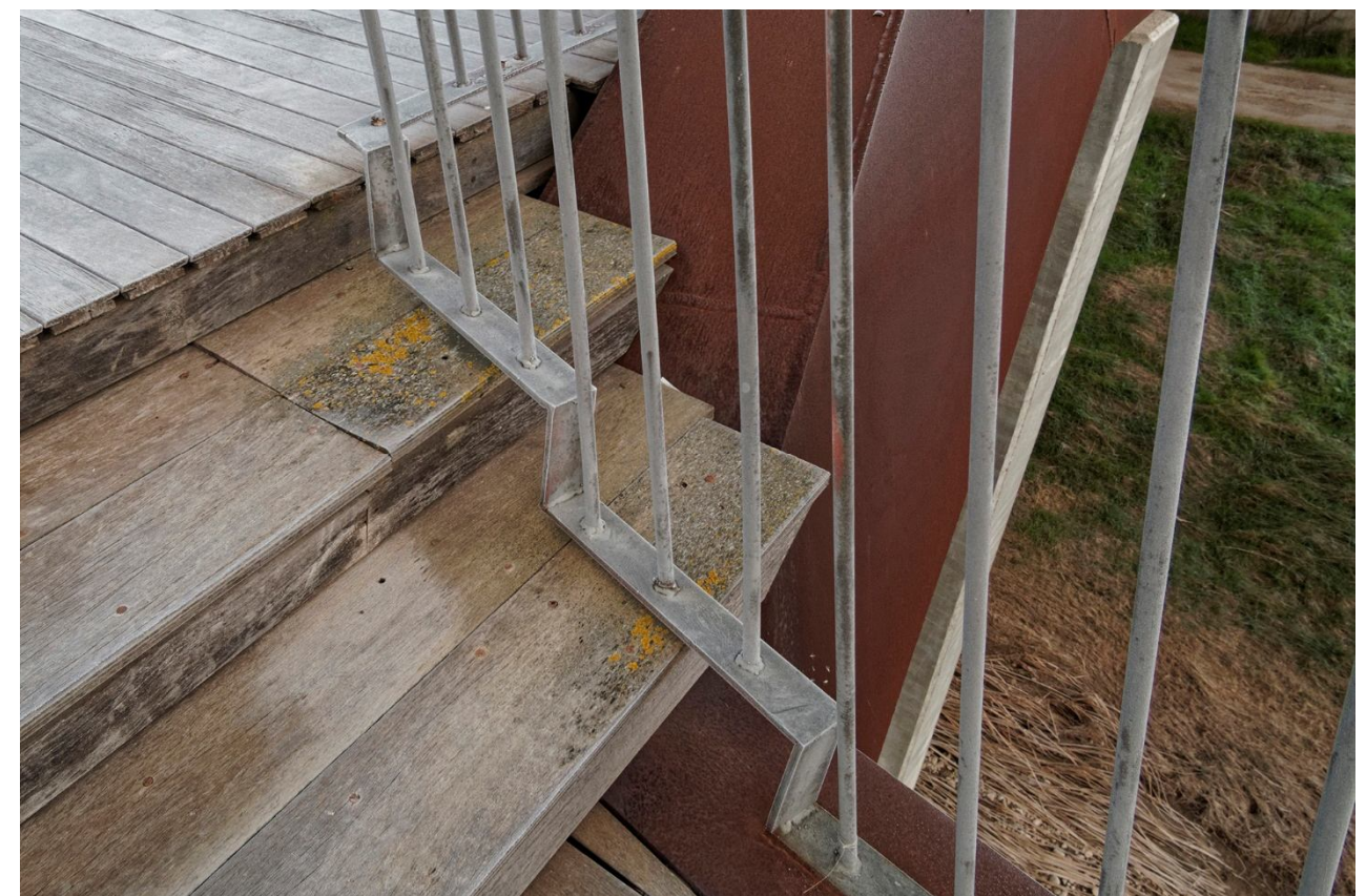
Imatge 6. Detall de la prolongació dels graons per sota de la barana
