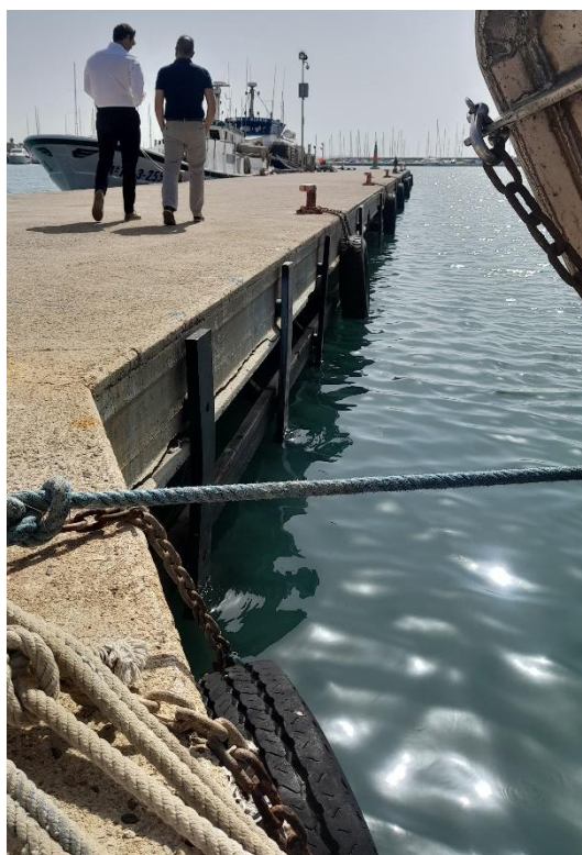
Figura 5 Estat del cantell de l'espigó amb les defenses
