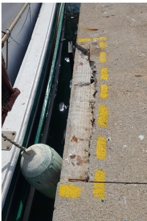
Figura 8 Detall de desperfectes observats al cantell del pantalà.
