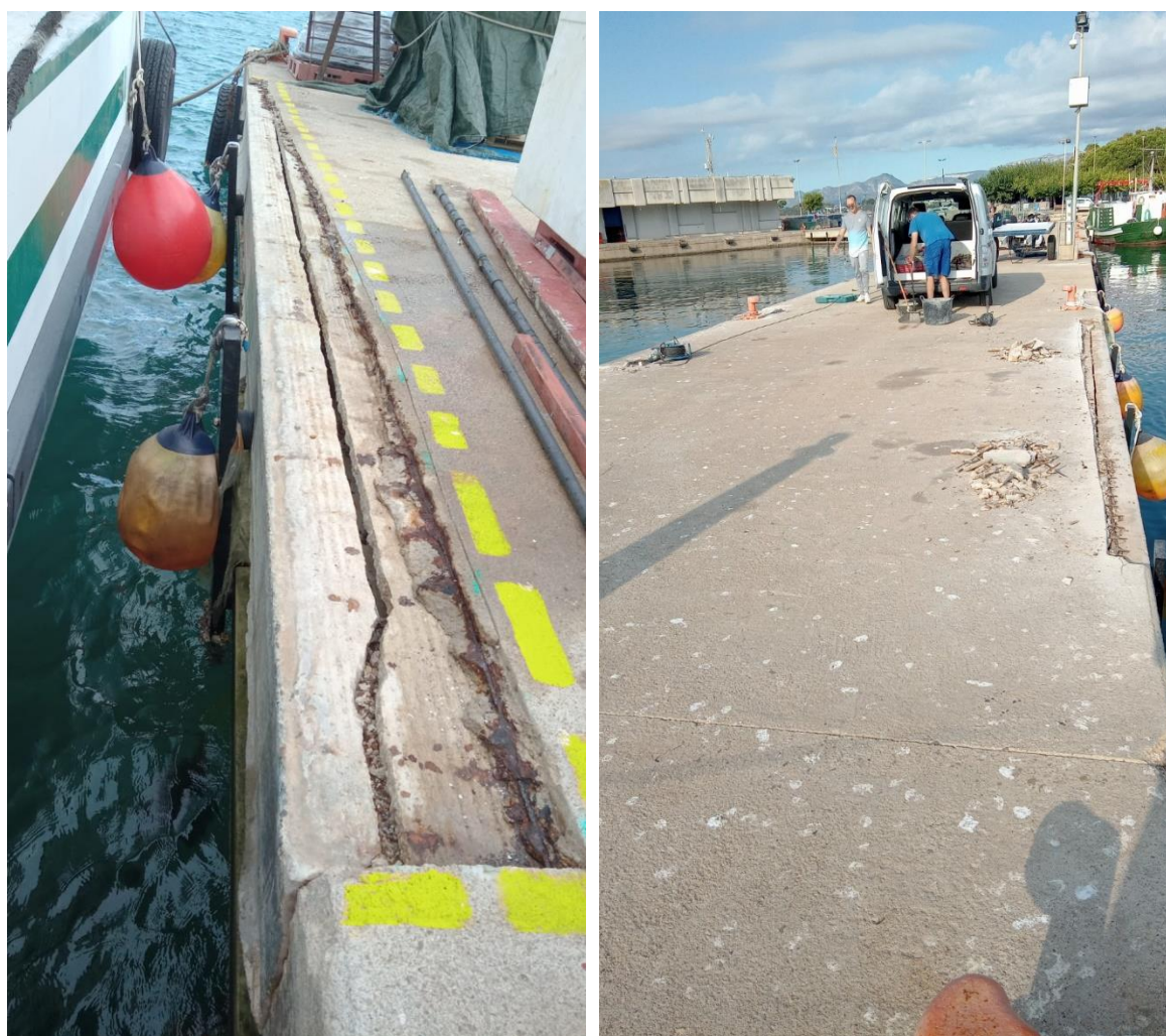
Figura 7 Estat actual del pantalà
