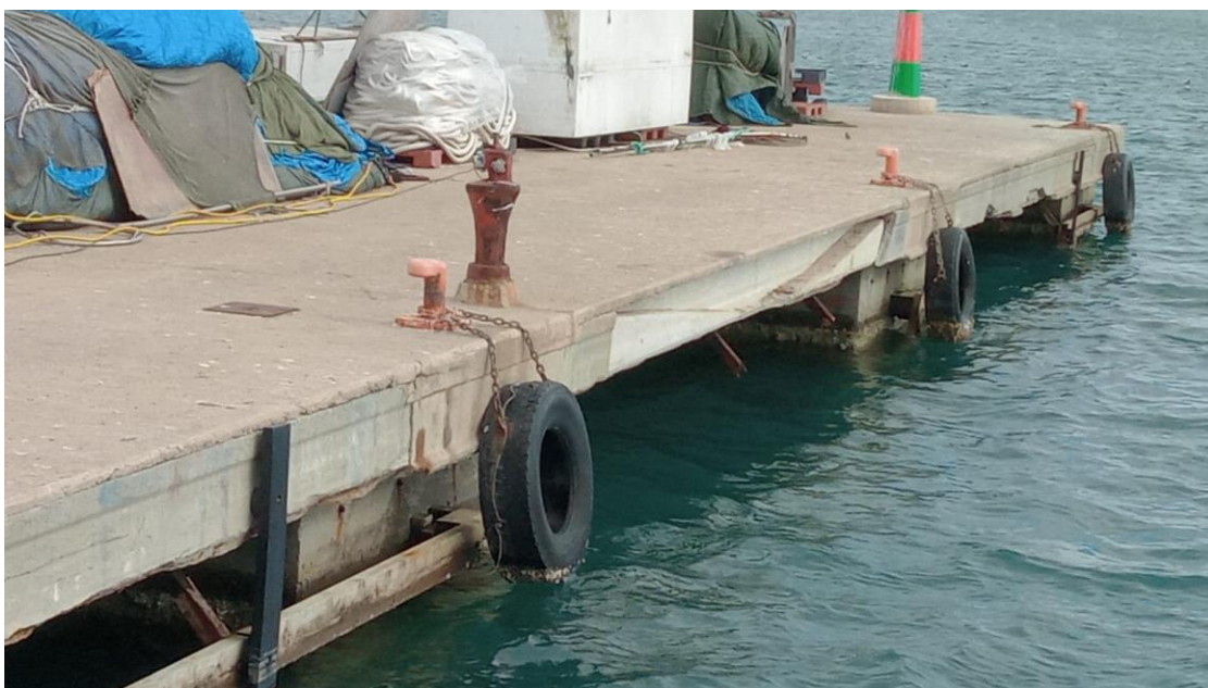
Figura 5 Estat actual del pantalà
