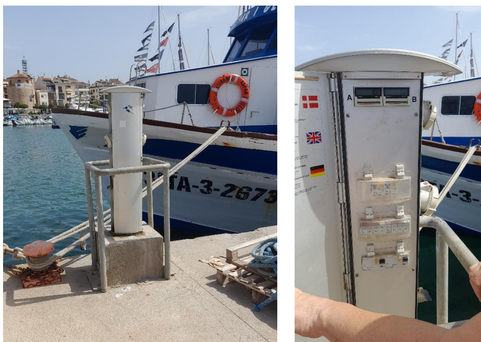
Figura 11 Torreta de servei i interior
