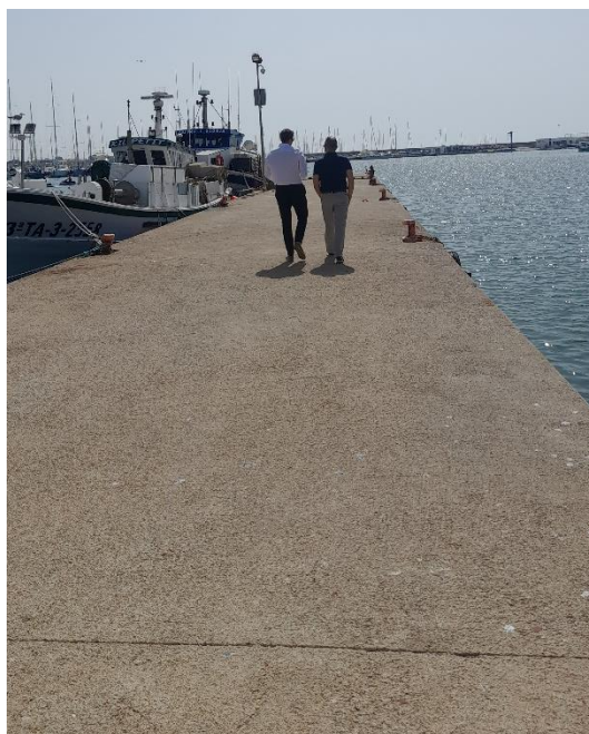
Figura 6 Vista de la segona alineació de l'espigó diagonal
