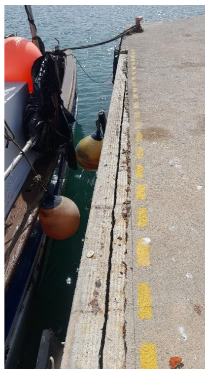
Figura 8 Detall de desperfectes observats al cantell del pantalà.
