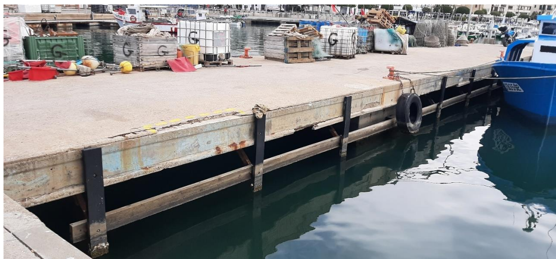
Figura 6 Estat actual del pantalà
