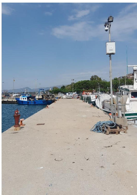
Figura 10 Vista general de l'espigó diagonal
