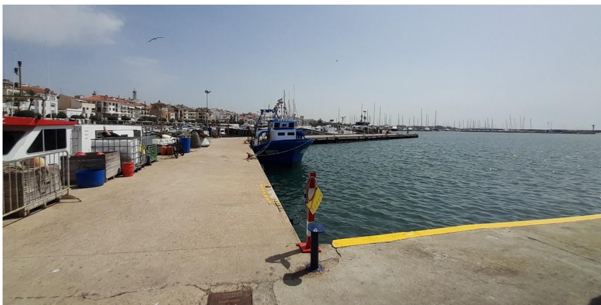
Figura 1 Vista general de l'espigó diagonal
