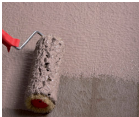
Impermeabilización de muro de cimentación a rodillo
