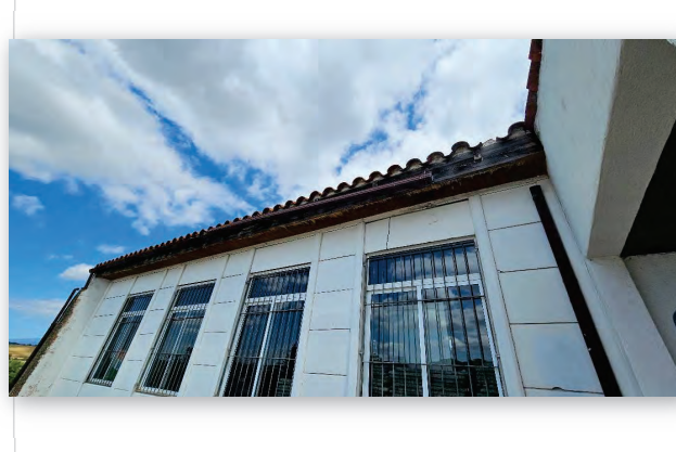
Detall del ràfec format per les pròpies encavallades
