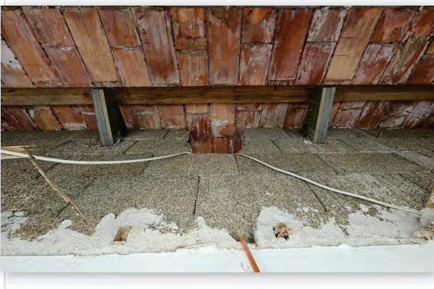
Detall constructiu amb els extrems de dos encavallades a la vista
