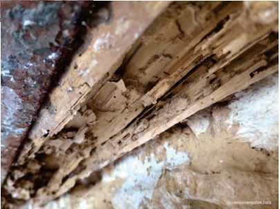
Degradació de la fusta causada pels tèrmits subterrànis
