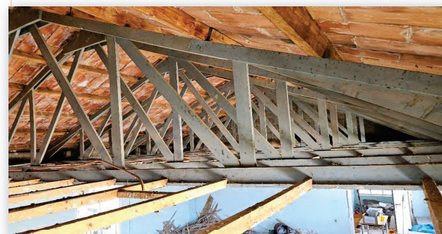
Detall configuració encavallades
