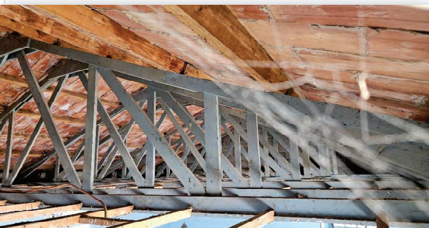
Detall configuració encavallades
