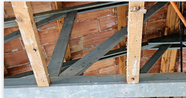
Detall configuració encavallada
