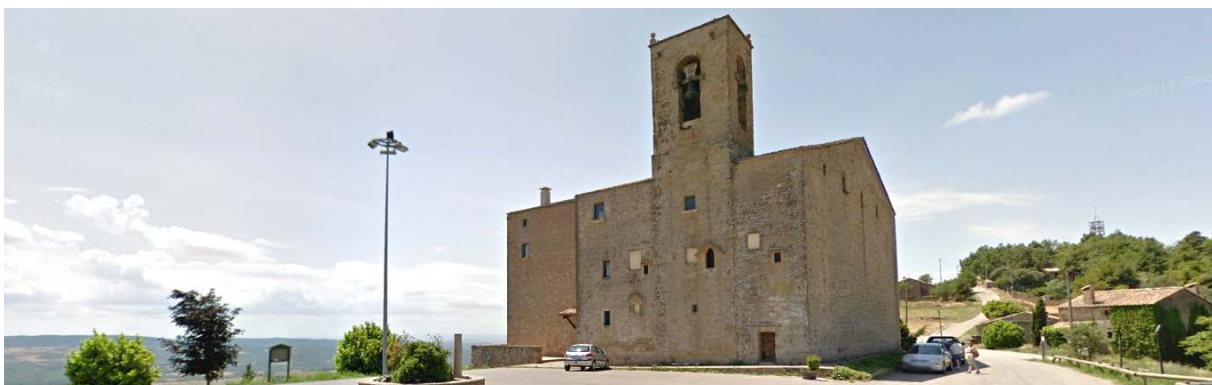
Fachada posterior del Santuario con el campanario
