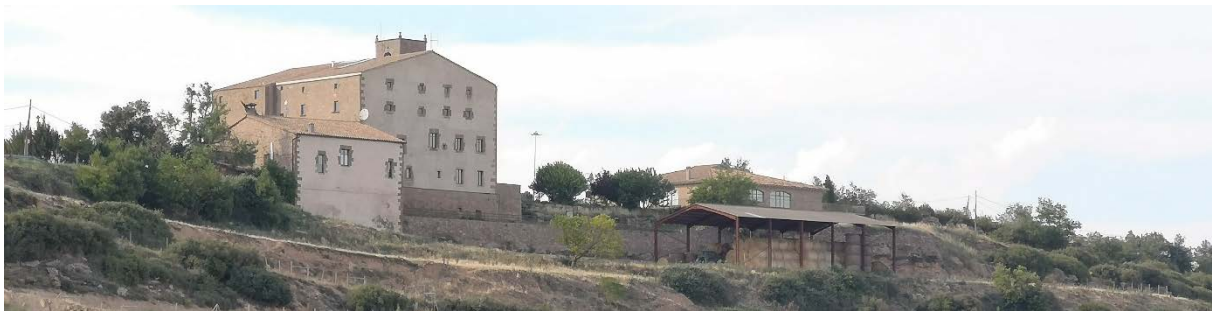
Fachada lateral sudeste, visuales sobre el territorio
