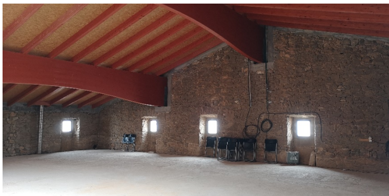
Estructura de la cubierta vista y ventanas de P3
