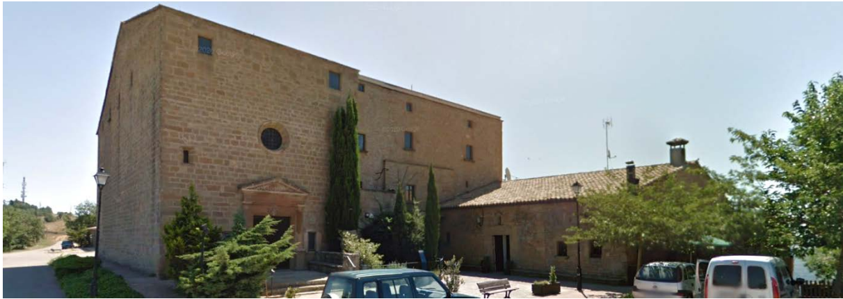
Fachada principal del Santuario Santa Maria de Pinós y plaza de acceso a la iglesia, santuario y hostel.
