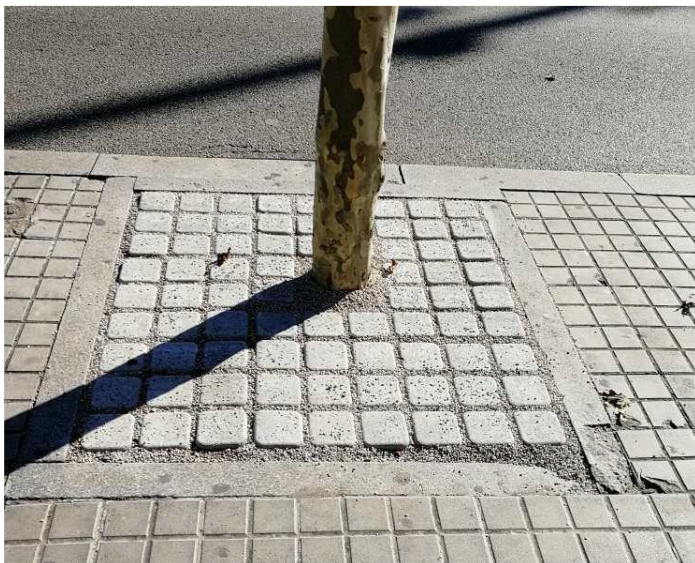
Foto 1. Exemple d'escocell amb solució de llambordí drenant
