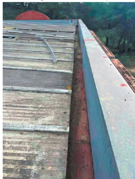
Detall canal recollida aigua
