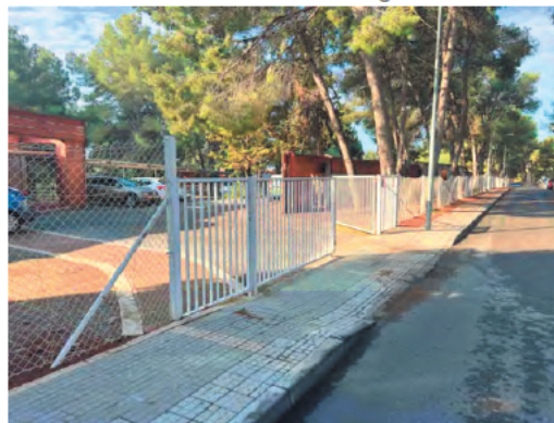
Tanca perimetral accés vehicles
