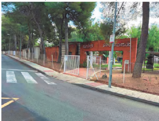
Tanca perimetral accés vianants
