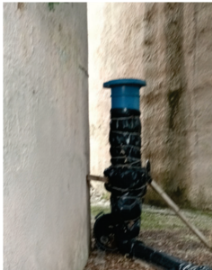
Figura 3. Imatge de l'accessori col·locat en el tub sobreexidor del dipòsit 3 per fer les proves de pressió.
