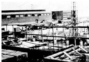
Fig. 1: Forjado protegido con barandilla
