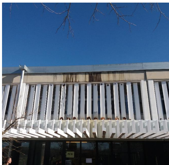
Imatge 2/3: Deteriorament de la façana
