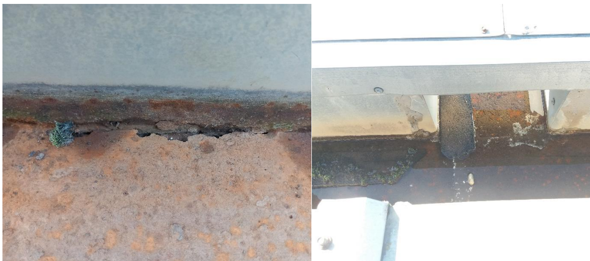
Foto 6: Detall de les patologies de les canals
