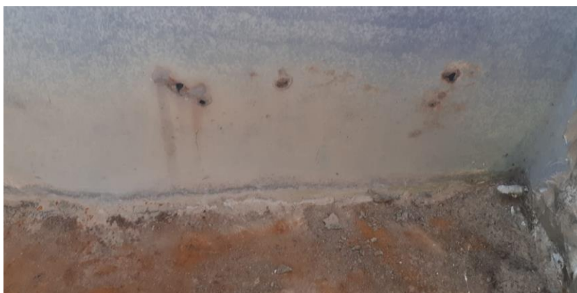
Foto 6: Detall de les patologies de les canals
