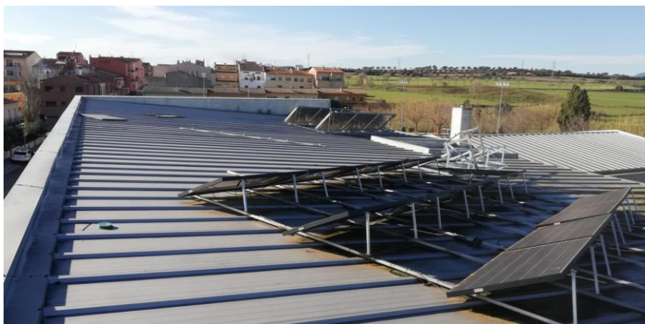
Foto 1: Deteriorament del pladur per Filtracions
