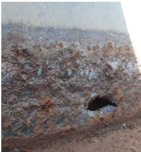
Foto 7: Detall de les patologies de les canals
