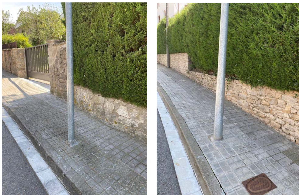
Vista als obstacles en la vorera
