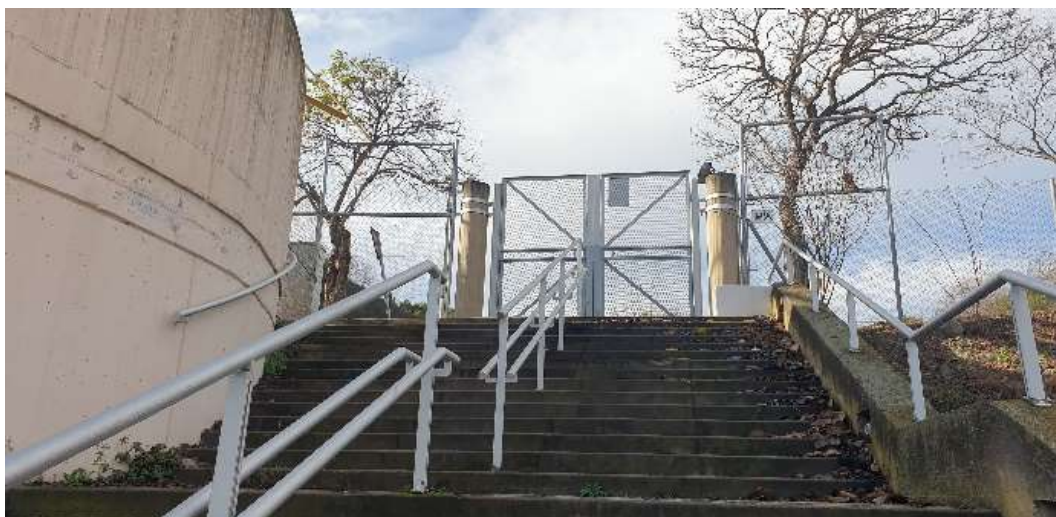
Vista des de l'interior. Recorregut ascendent (P2)
