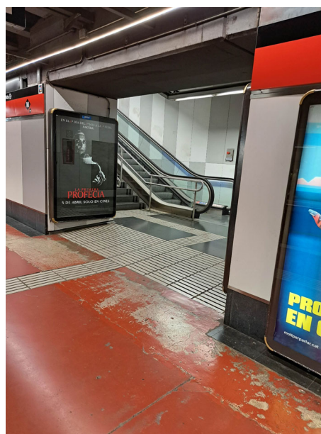
Accés a vestíbul
