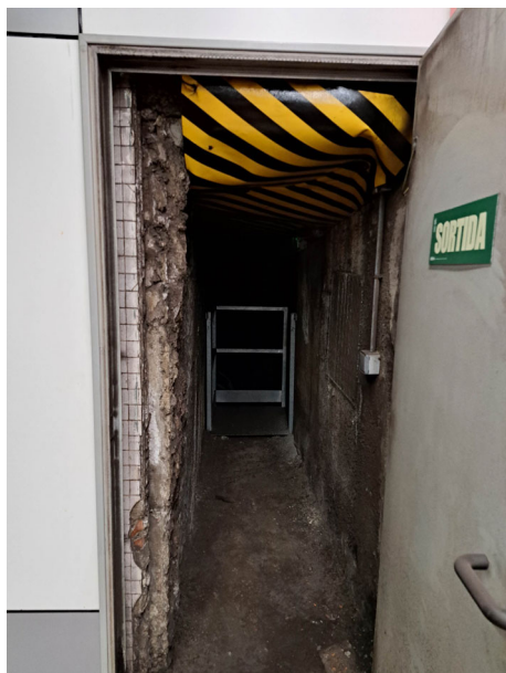
Accés pou de ventilació via 2
