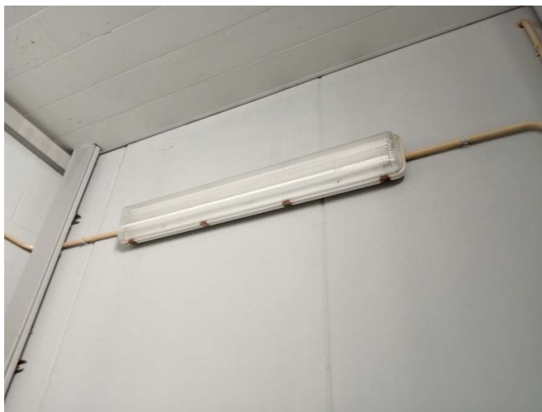
Fotografia 12: Estat actual de la sala de quadres
