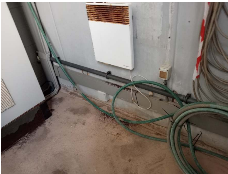
Fotografia 11: Estat actual de l a sala de quadres
