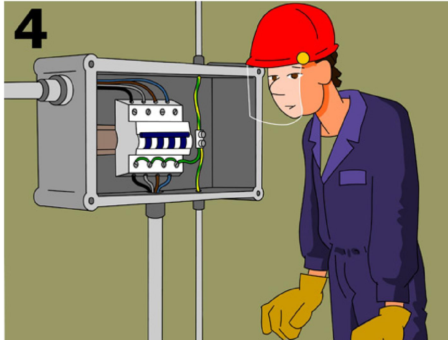
4.- CURT-CIRCUITAR I POSAR A TERRA LA INSTAL·LACIÓ
