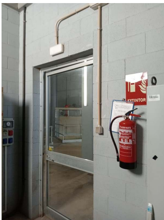
Fotografia 9: Estat actual de l'accés a sala de quadres
