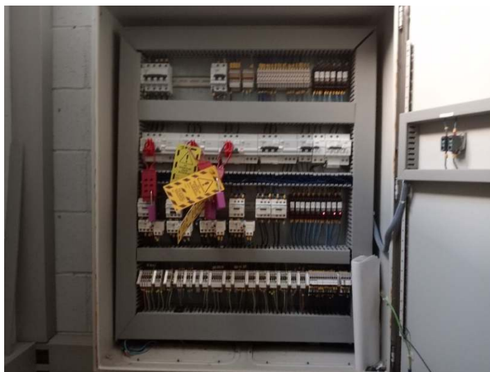
Fotografia 4: Estat actual quadre 01PLA1207
