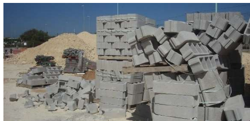
Rotura de material por acopio indebido
