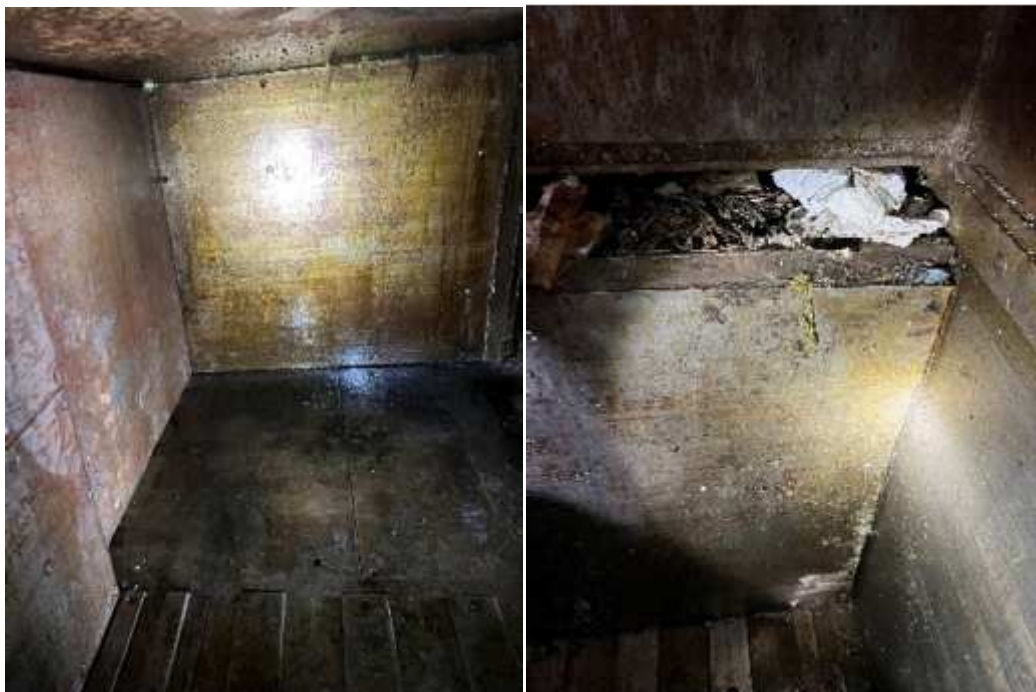
Fig. 2.- Estat actual de la càmera de compactació i del plat premSOR.
