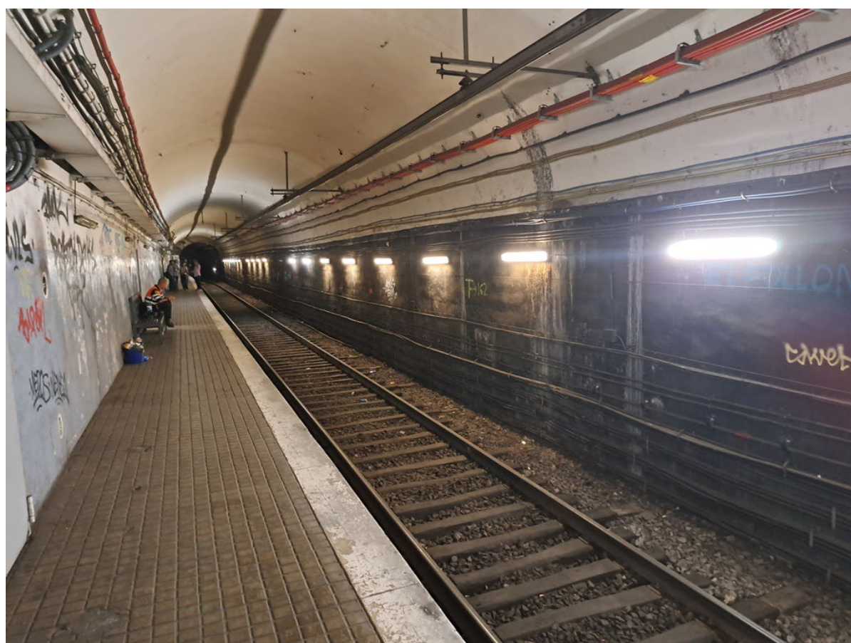
Andana i estacionament a via 3
