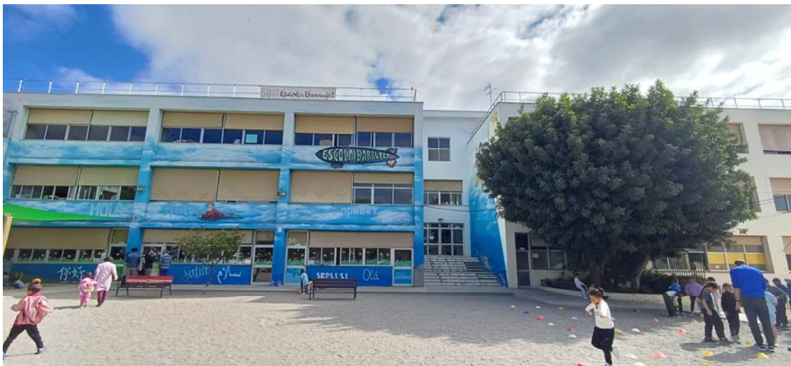
Img.2 i 3 – Vista exterior: façana sud
