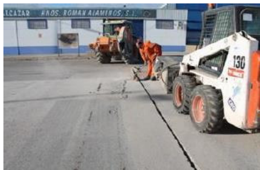
Figura 44. Exemple de rasa.
