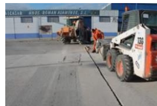
Figura 51. Escombratge de material amb minicarregadora.
