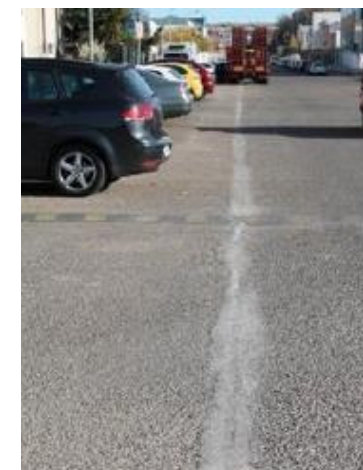
Figura 54. Rasa finalitzada amb formigó.
