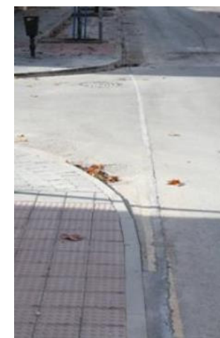
Figura 48. Exemple de rasa coberta i acabada.
