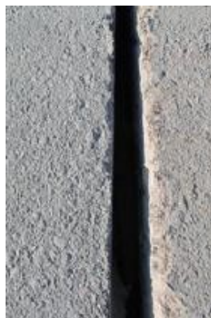
Figura 50. Tall típic de micro-rasa
