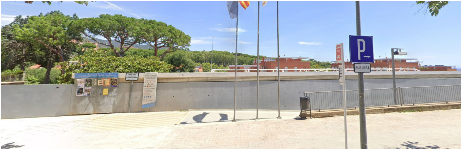
ESTAT ACTUAL ZONA ACCÉS
