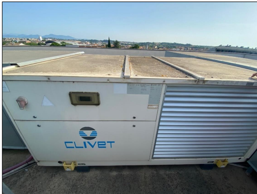
Figura 6. Emplaçament de l'actuació de substitució de la recuperadora
